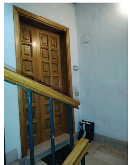
Portone di ingresso dalla scala
