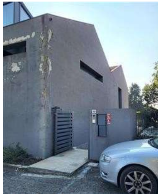
Accesso pedonale di servizio
