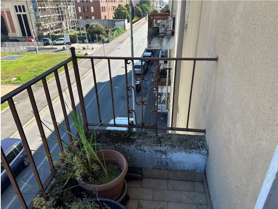
Foto 9 – Balcone lato strada
