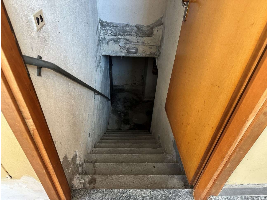
Foto 13 – Scala verso cantina
