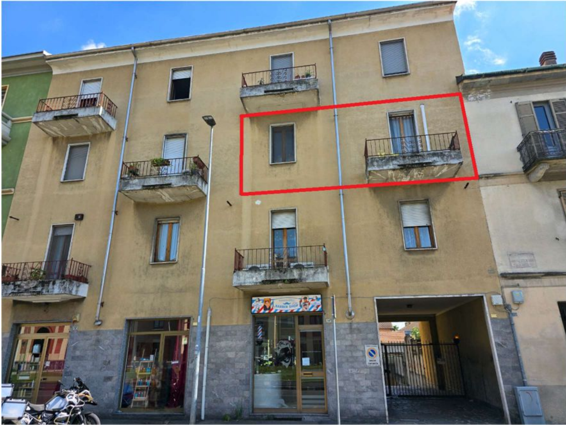
Foto 1 – Vista esterna lato strada
