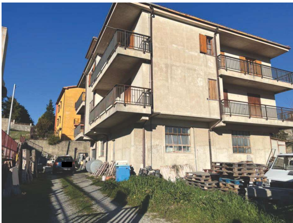
Foto 1 – Vista esterna intero fabbricato
