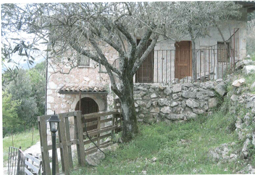
Fabbricato visto da est
