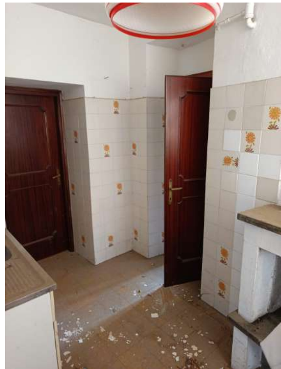
Foto n. 21-23: vista della cucina. Dettaglio del distacco tinteggiatura e infiltrazioni soffitto.
