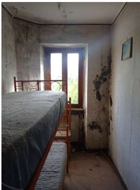
Foto n. 26-28 vista della stanza adibita a camera da letto. Dettaglio infiltrazione e muffe.
