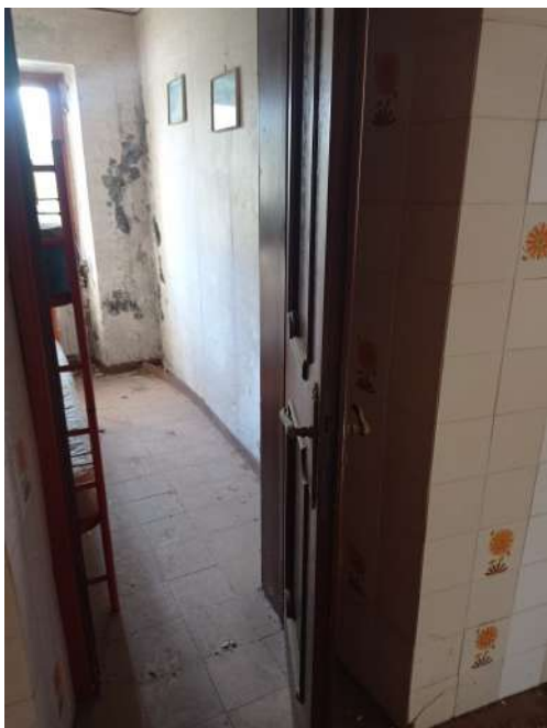
Foto n. 26-28 vista della stanza adibita a camera da letto. Dettaglio infiltrazione e muffe.
