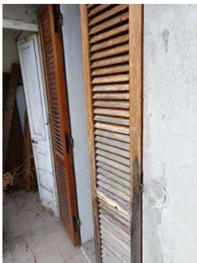
Foto n. 40: Dettaglio infissi esterni.
