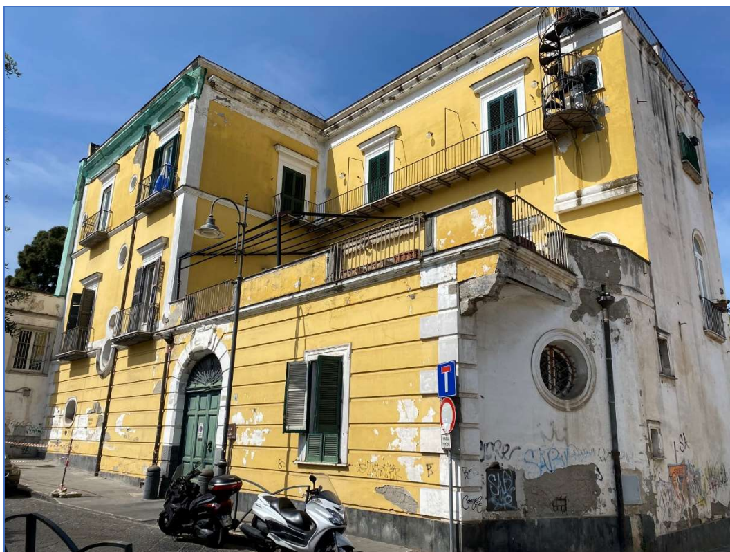
FOTO 2. PROSPETTI EST E NORD.
