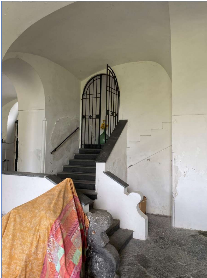
FOTO 5. ACCESSO VANO SCALA DALL'ANDRONE.
