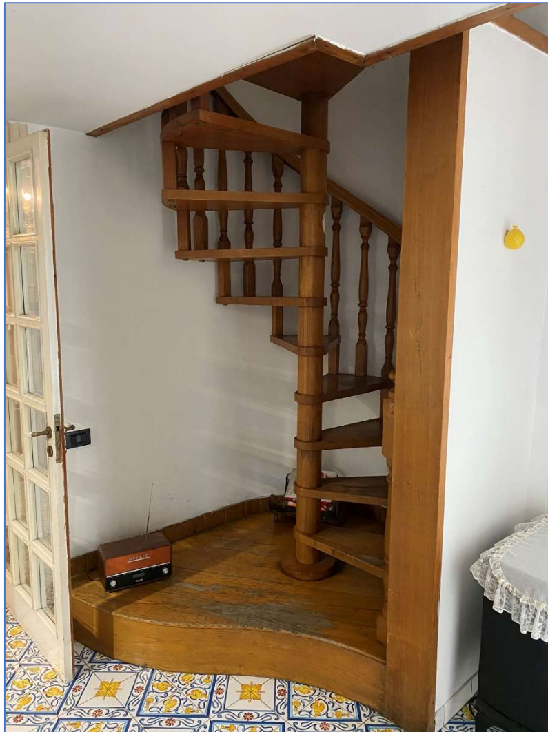
FOTO 22. SCALA DI ACCESSO AL SOPPALCO.
