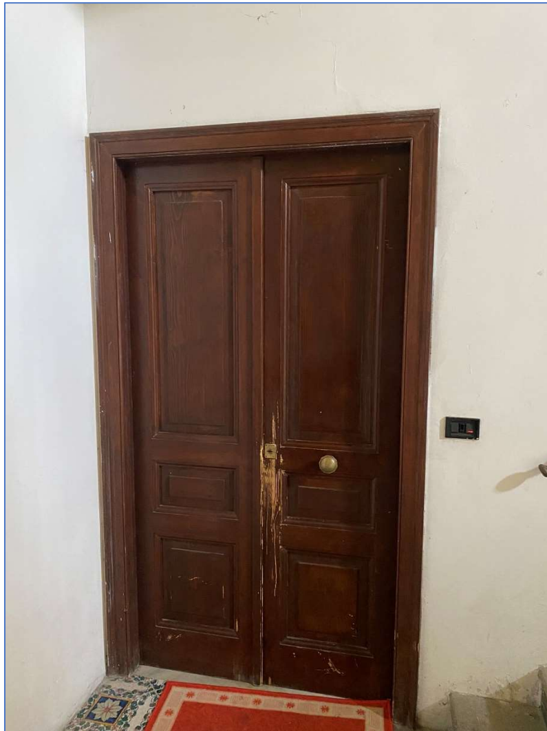
FOTO 8. INGRESSO IMMOBILE (PORTA A DESTRA).
