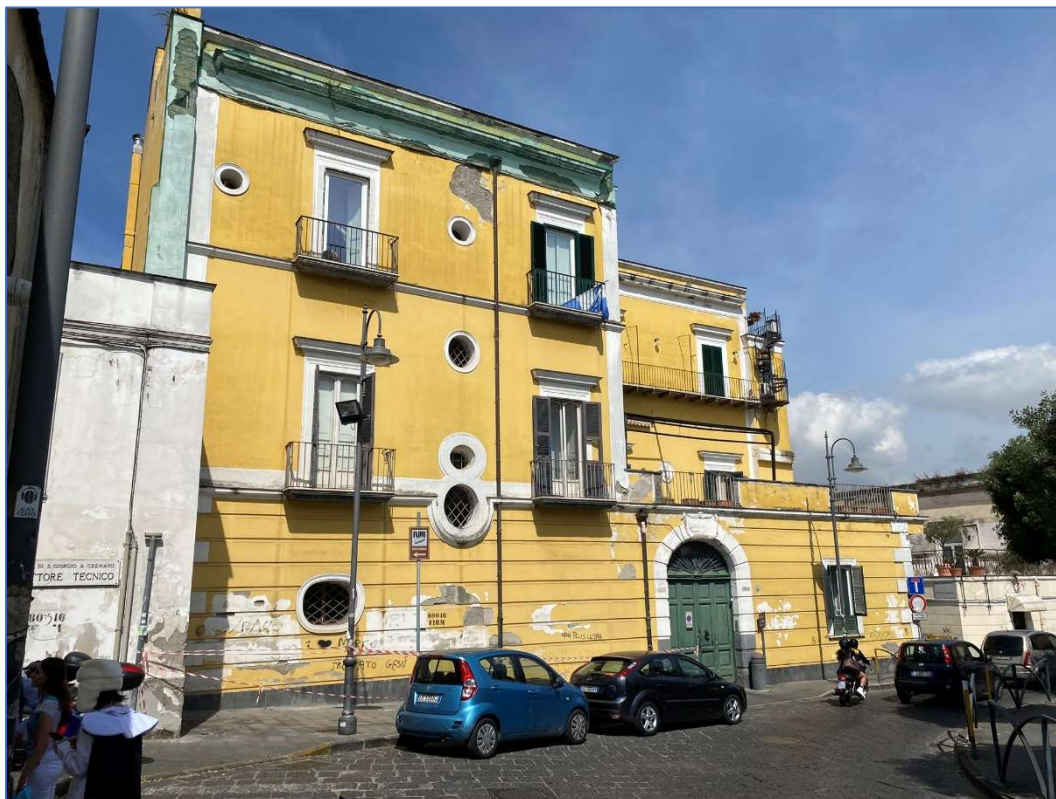
FOTO 1. PROSPETTO EST FABBRICATO SU VIA CAVALLI DI BRONZO.
