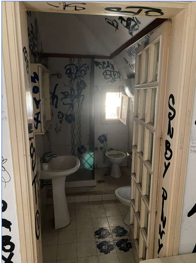
FOTO 25. BAGNO SU SOPPALCO [#9].
