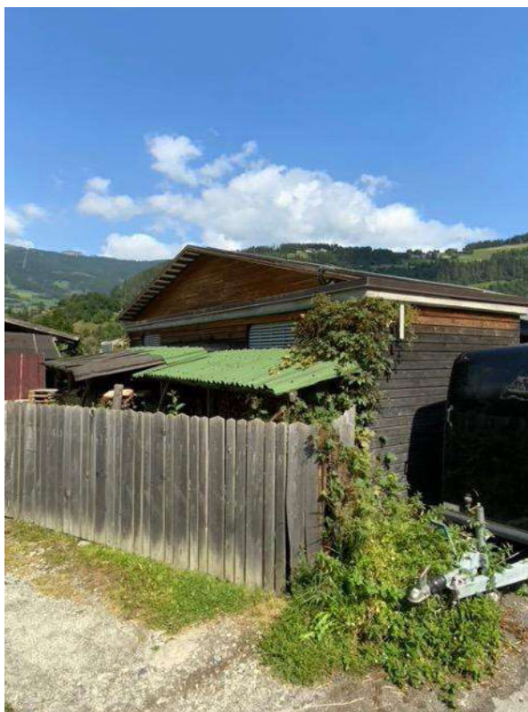
viste esterne delle cabine di trasformazione
