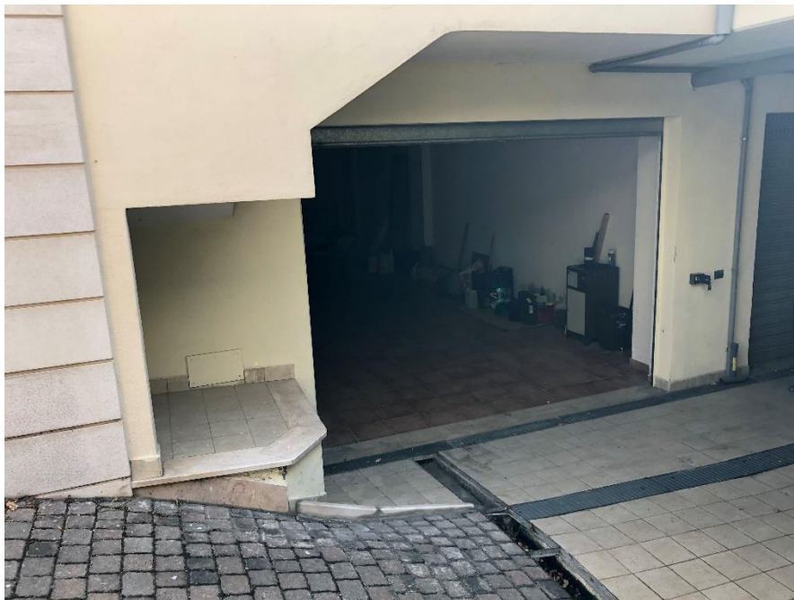
Foto n. 4: Ingresso locale autorimessa
