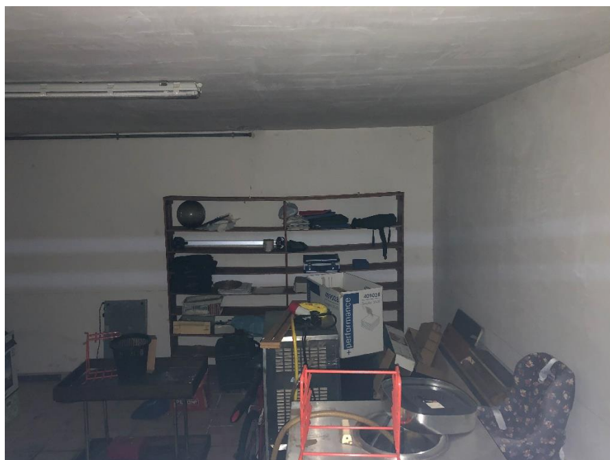
Foto n. 8: Locale autorimessa sub. 13
