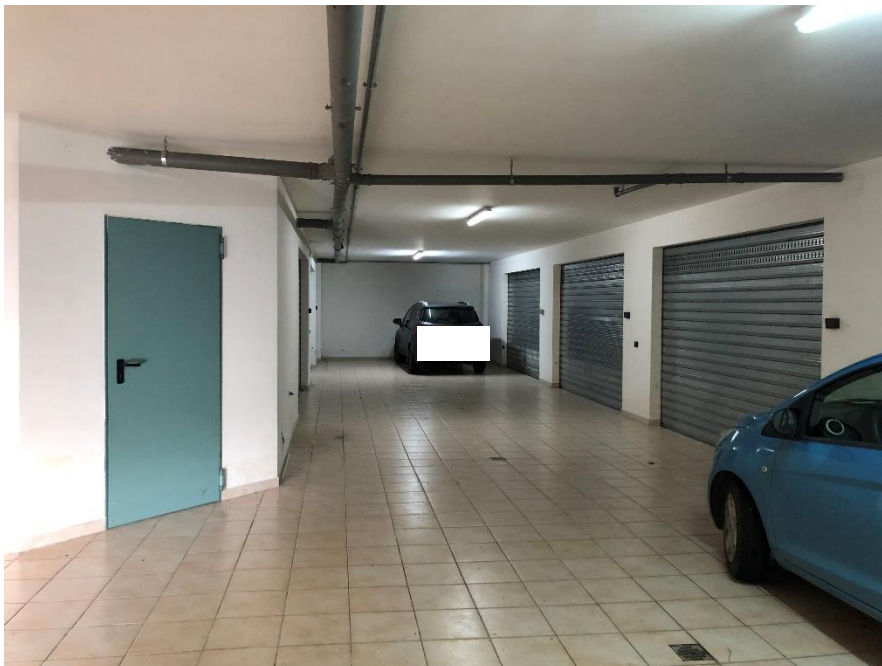
Foto n. 4: Area di manovra
