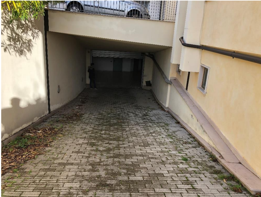
Foto n. 3: Rampa d'accesso all'area di manovra
