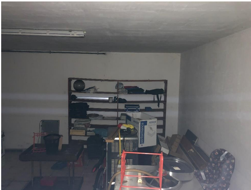
Foto n. 6: Locale autorimessa sub. 13
