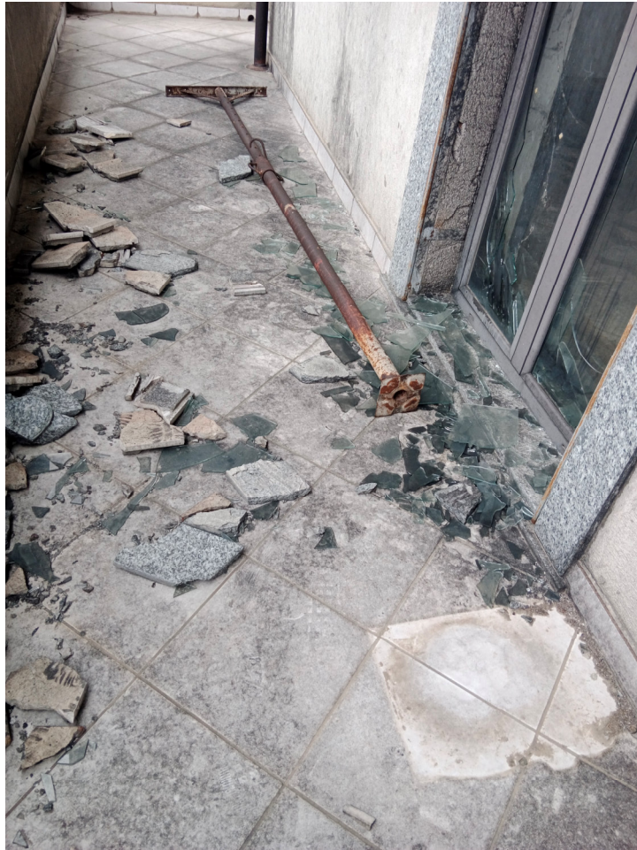
Vista balcone – infissi primo piano
