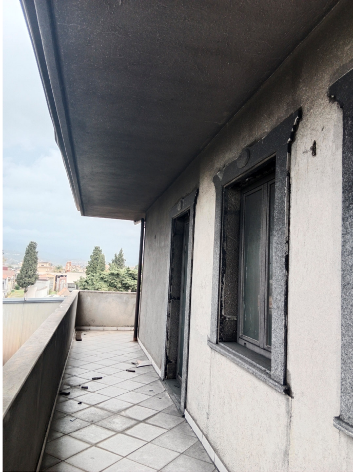
Vista balcone secondo piano
