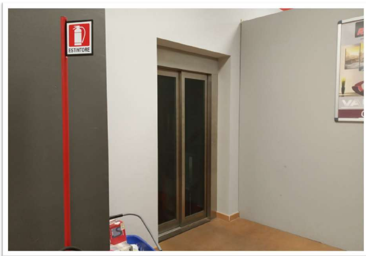
FOTO 19 Vista vano ascensore
