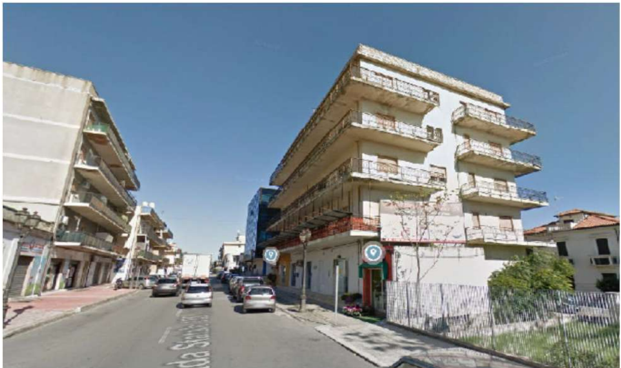
Vista generale dell'immobile su corso Vittorio Emanuele (SS106) ARCH. LUCIA SACCA' - CTU -
