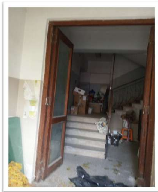
FOTO 2 Vano scala di accesso al piano cantina ARCH. LUCIA SACCA' - CTU -
