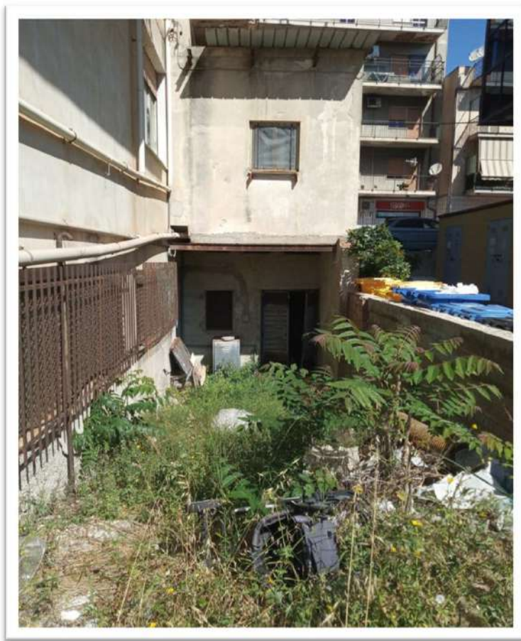
FOTO 3 Rampa di accesso al piano cantina
