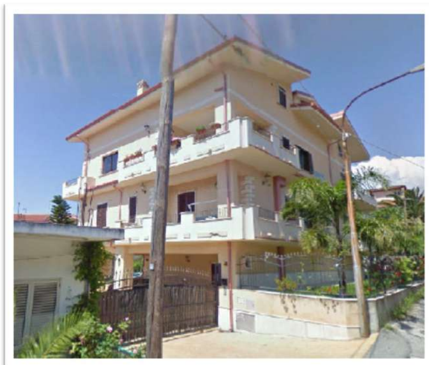
FOTO 1 VISTA D'INSIEME DEL FABBRICATO
