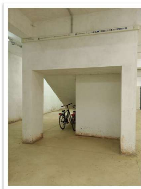
FOTO 2 LATO VANO SCALA
