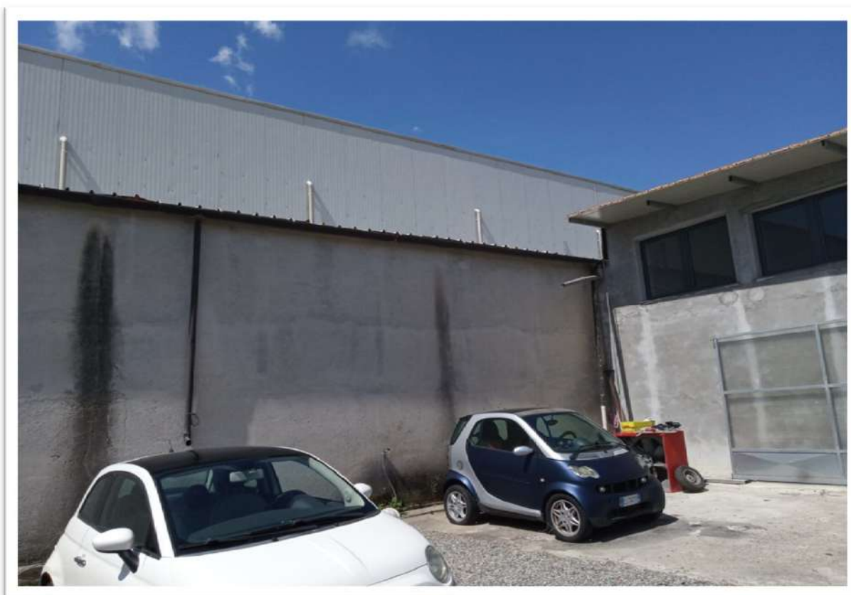
Vista area esterna al locale officina realizzato in aderenza al capannone (part.IIa 369) ARCH. LUCIA SACCA' - CTU -
