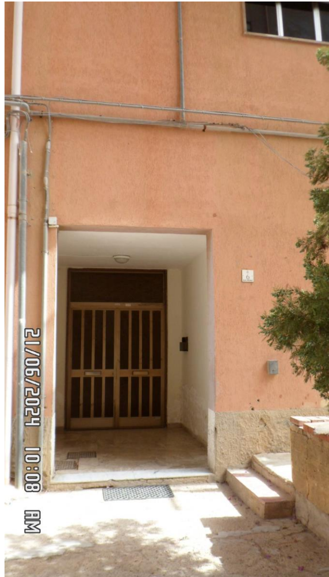
Foto 4 – Veduta del portone d'ingresso
