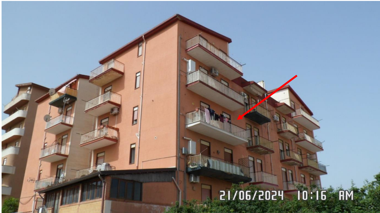
Foto 1 – Veduta dell'appartamento a terzo piano da via Unità d'Italia
