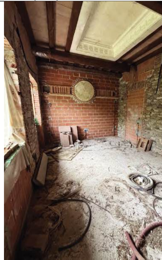
Locale al piano primo
