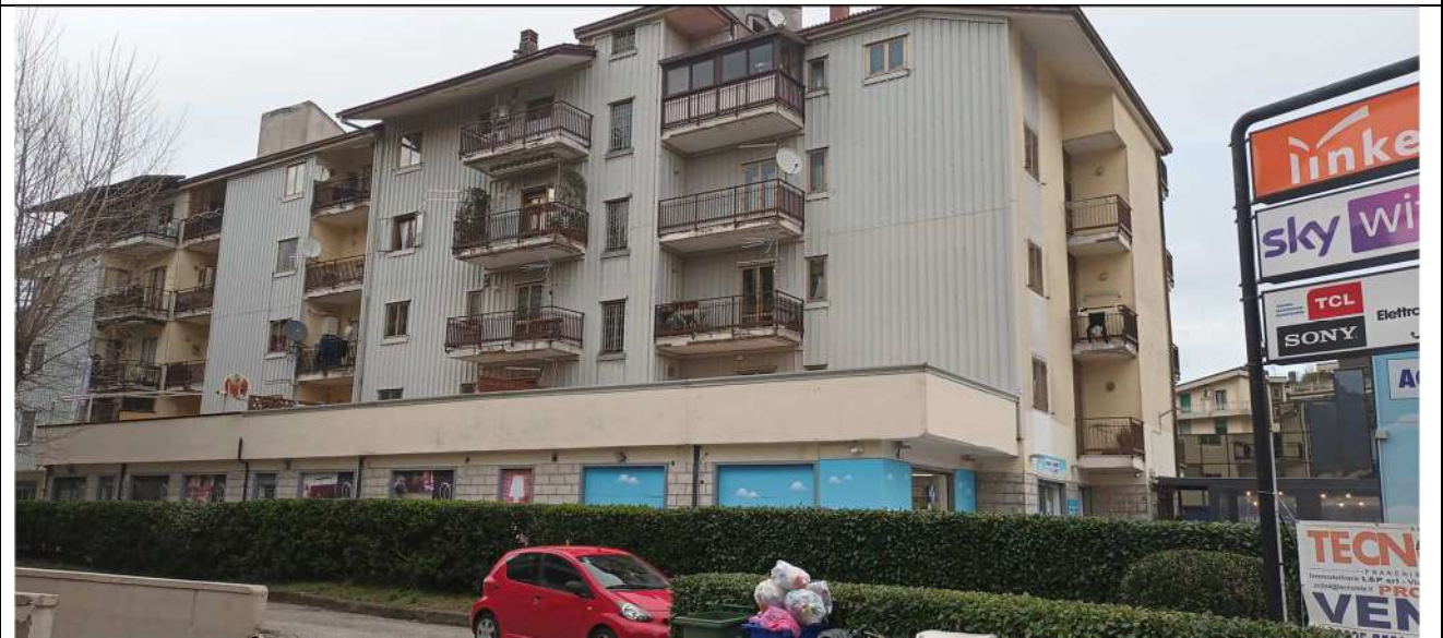
Foto 2 Vista fabbricato lato Ovest
