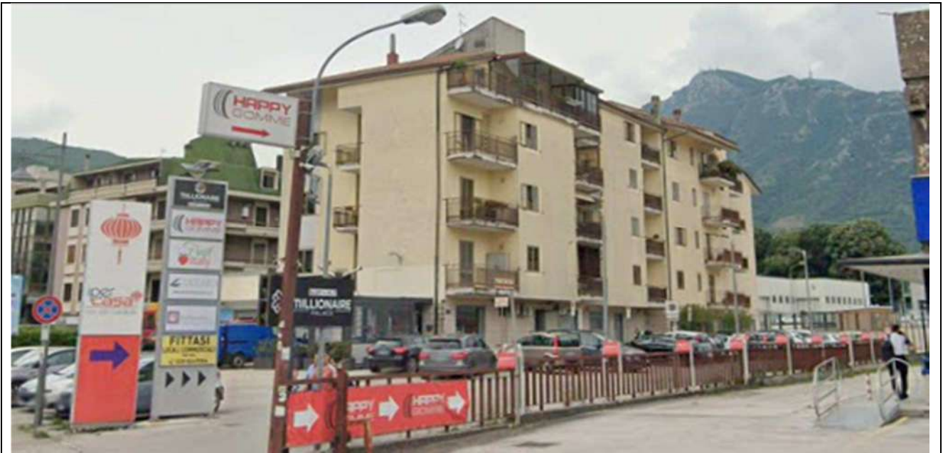
Foto 4 Vista fabbricato da Via Nazionale
