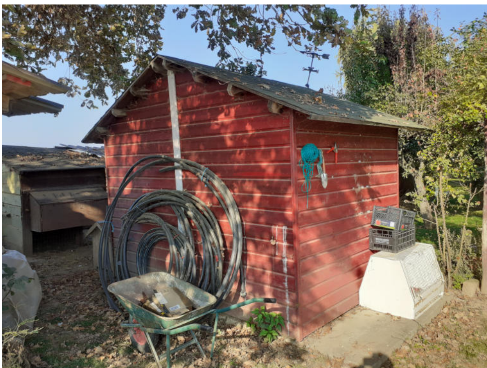
FOTO 28 – BASSO FABBRICATO DA DEMOLIRE
