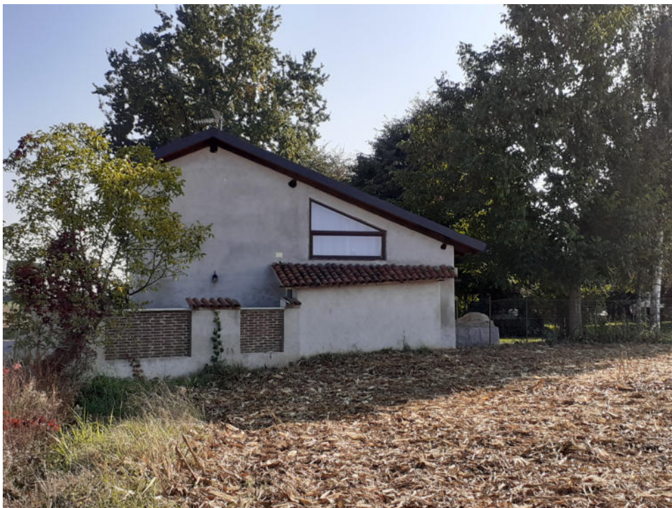
FOTO 1 – VISTA LATO OVEST
