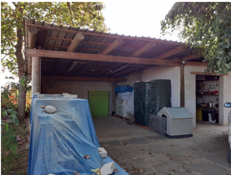
FOTO 33 – TETTOIA DA DEMOLIRE
