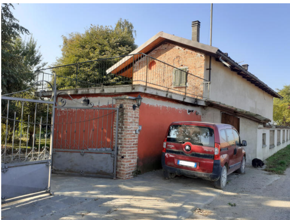
FOTO 2 – VISTA LATO NORD
