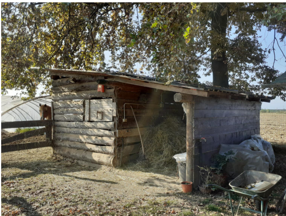
FOTO 27 – BASSO FABBRICATO DA DEMOLIRE
