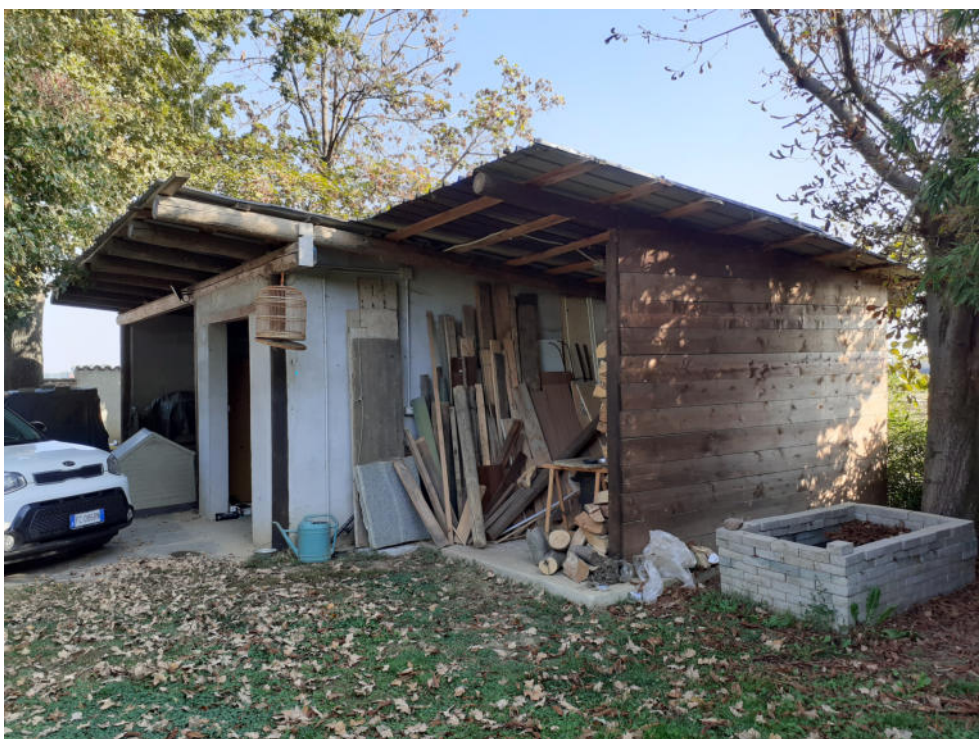
FOTO 34 – BASSO FABBRICATO DA DEMOLIRE
