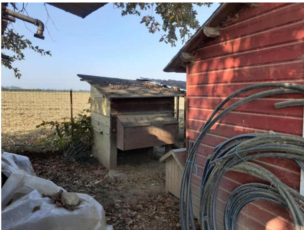
FOTO 29 – BASSO FABBRICATO DA DEMOLIRE
