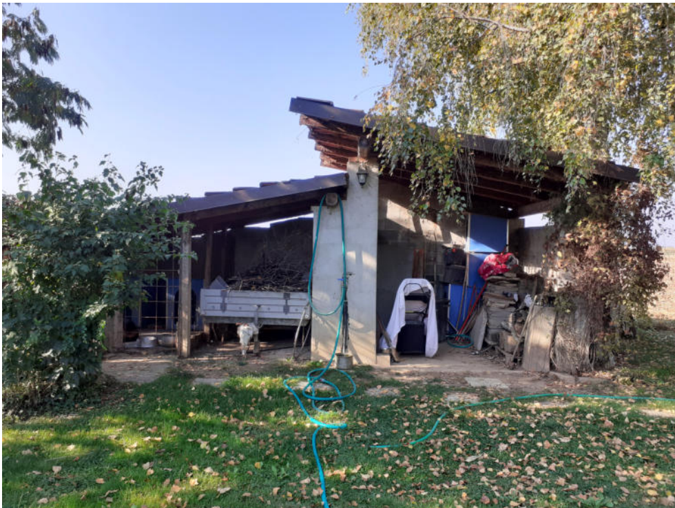
FOTO 32 – BASSO FABBRICATO DA DEMOLIRE
