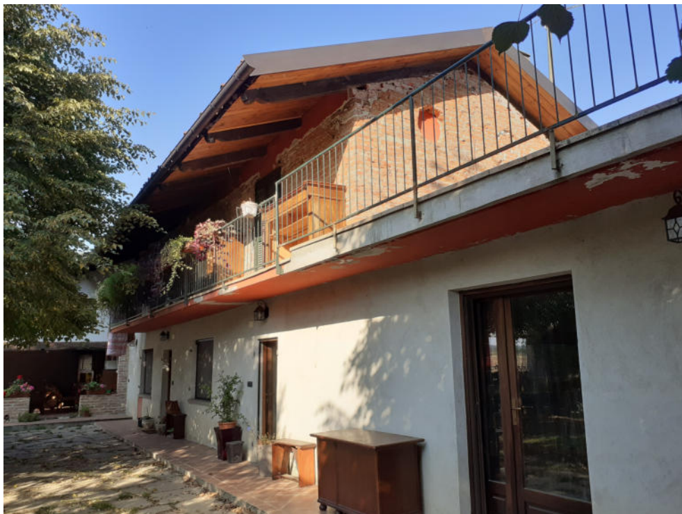
FOTO 4 – VISTA LATO SUD
