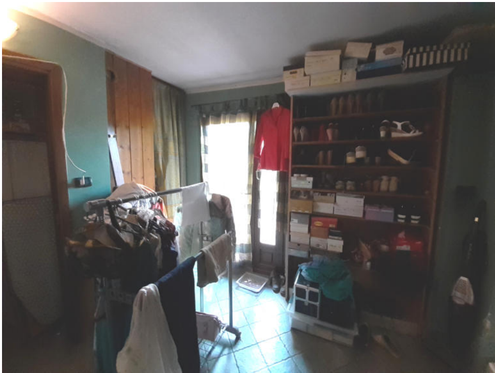
FOTO 17 – PORTAFINESTRA DIFFORME MAGAZZINO LATO INTERNO
