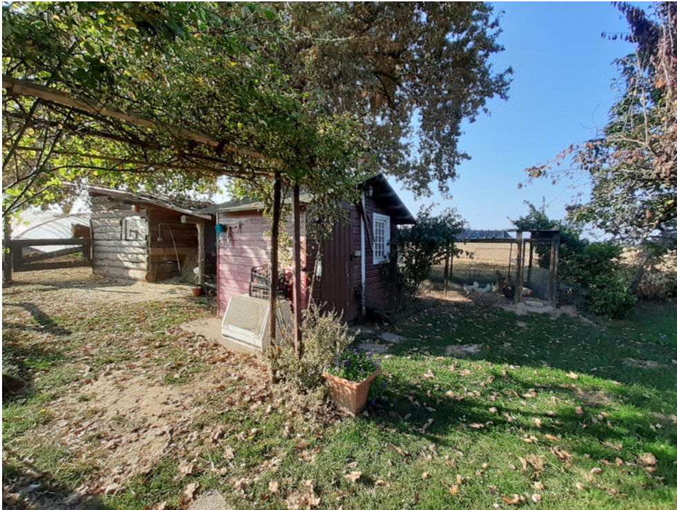
FOTO 31 – BASSO FABBRICATO DA DEMOLIRE
