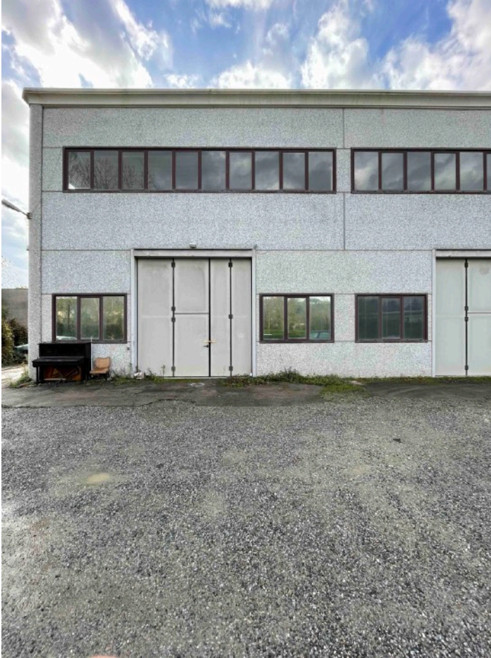
INGRESSO DA VIA A. MORO
