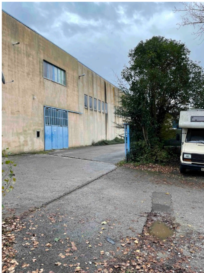
INGRESSO AL LOTTO DA VIA A. MORO
