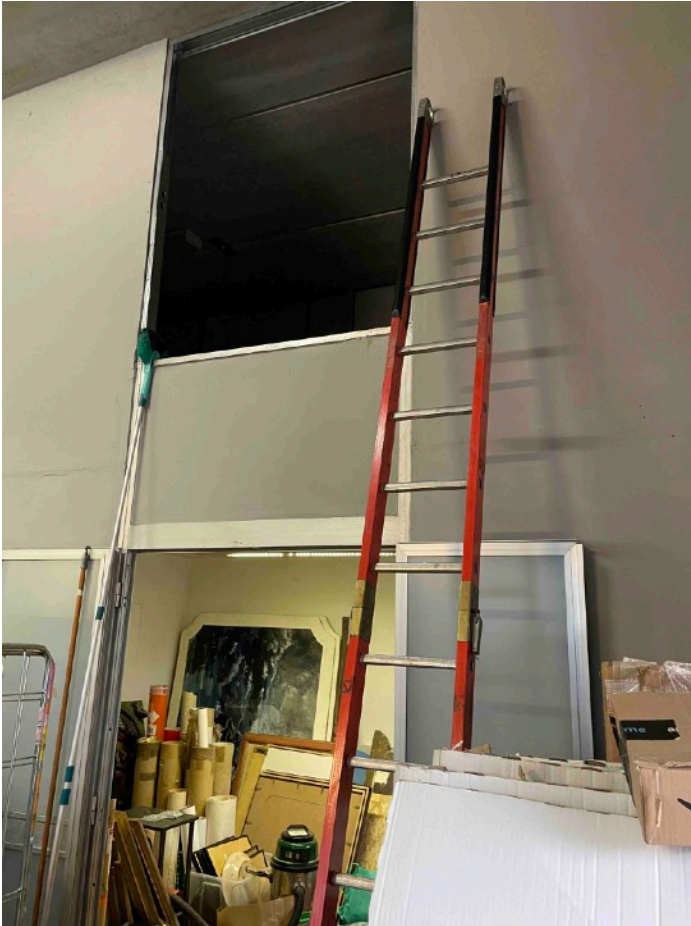
ACCESSO ALLA SOFFITTA (privo di scala fissa)
