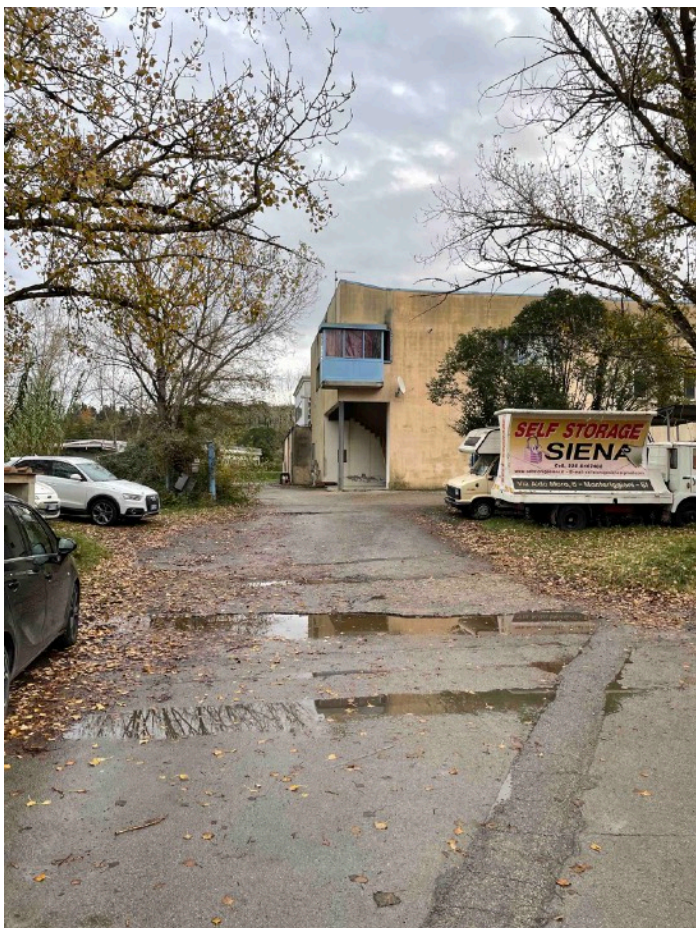
INGRESSO AL LOTTO DAL PARCHEGGIO PUBBLICO
