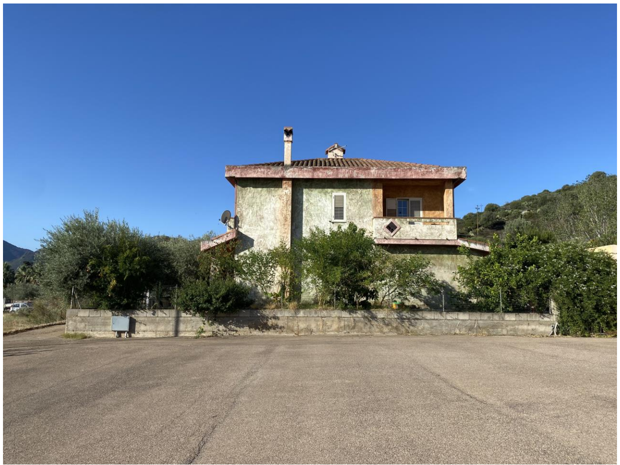
Foto 1 - Immobile B - Prospetto principale dalla via Ariosto
