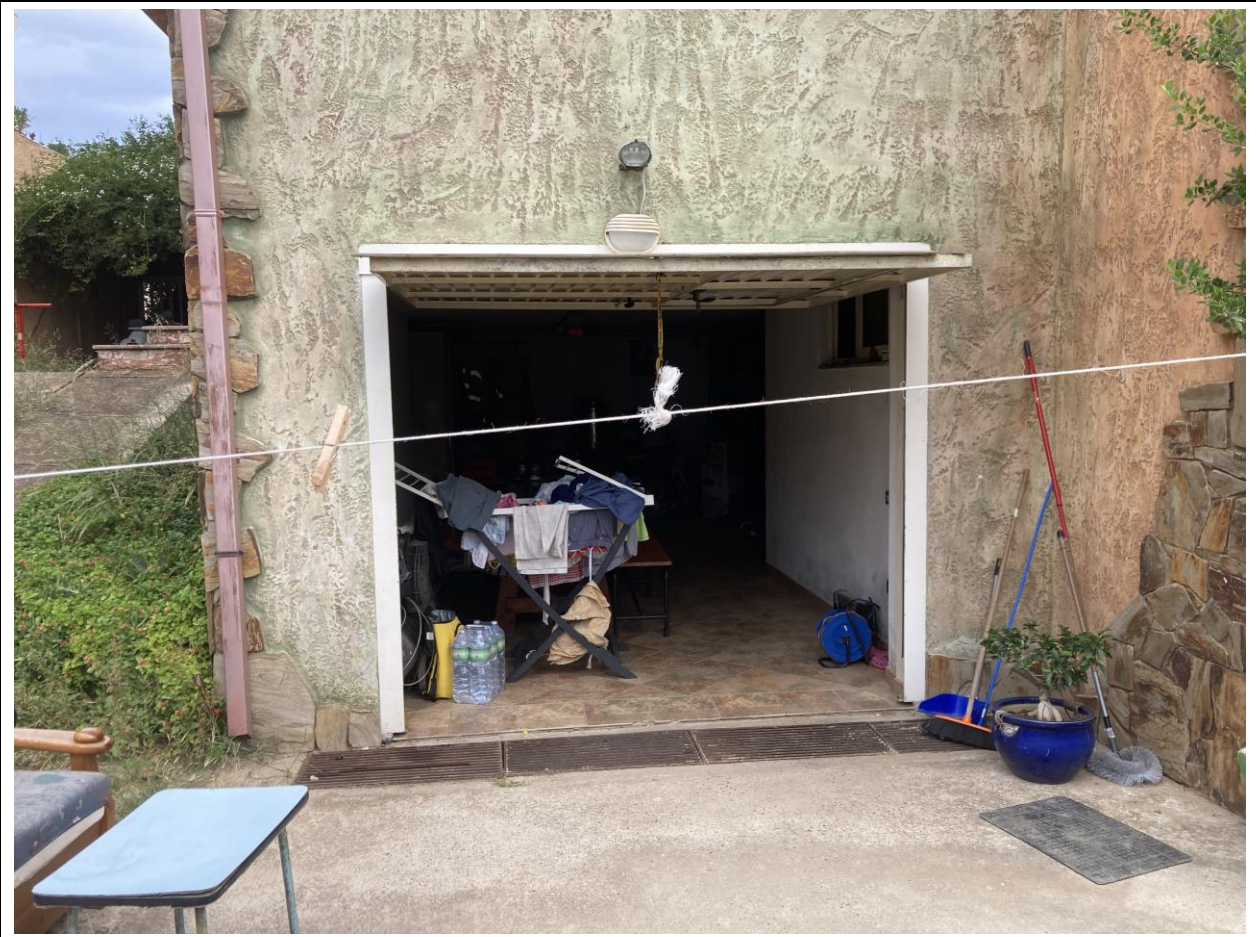
Foto 5 - Immobile B - Ingresso al piano seminterrato
