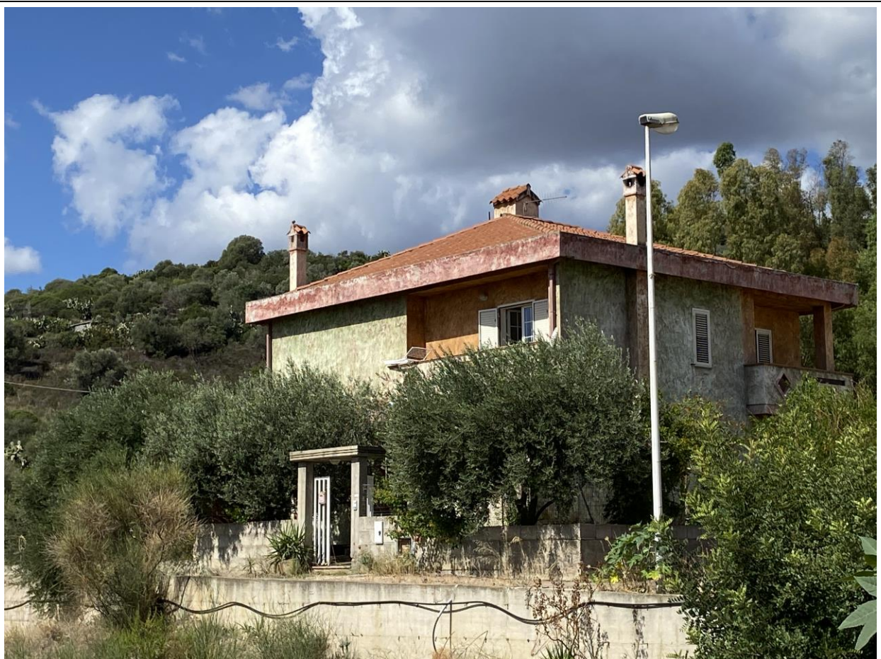
Foto 2 - Immobile B - Prospetto laterale dalla via Ariosto (ingresso pedonale)
