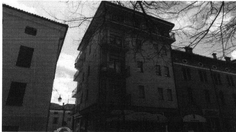
Vista Condominio Cavallino
