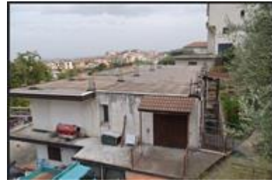
foto della copertura
