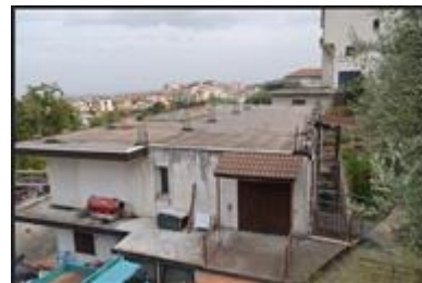
foto della copertura
