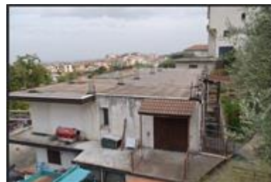
foto della copertura
