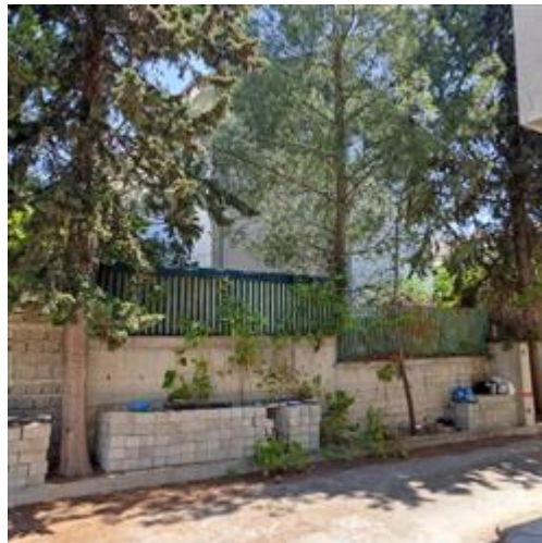
Foto recinzione perimetrale
