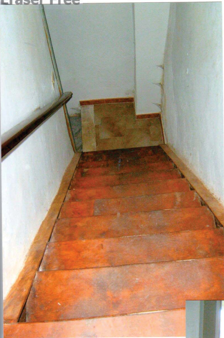
SCALA DI COLLEGAMENTO TRA IL PIANO TERRA ED IL PRIMO
