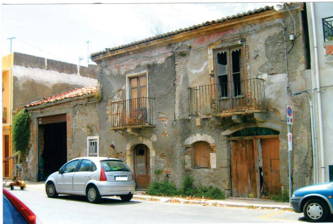
FACCIATA SU VIA AVV. LUDOVICO FULCI
