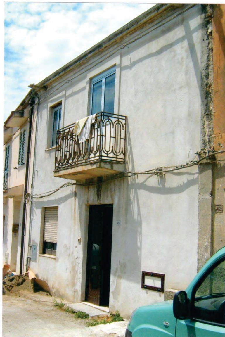
FACCIATA SU VIA TENENTE SALVATORE SIRACUSA
