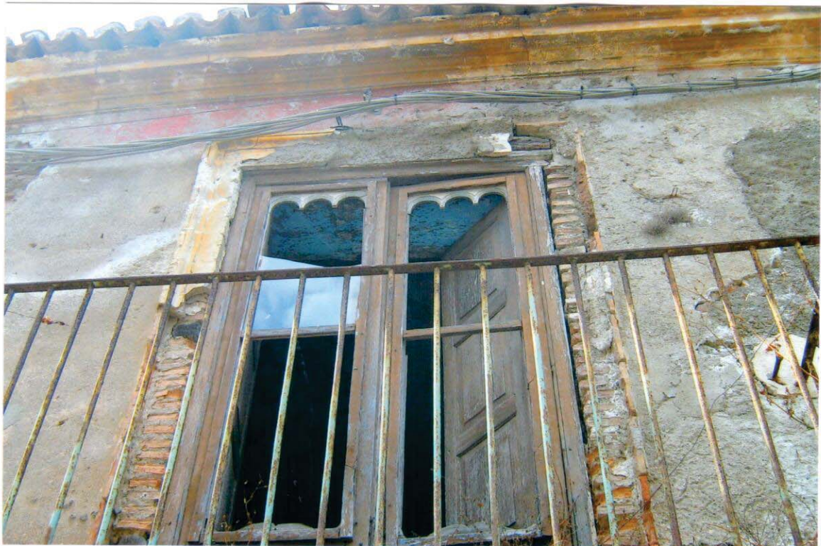
PARTICOLARE BALCONE APPARTAMENTO PIANO PRIMO
