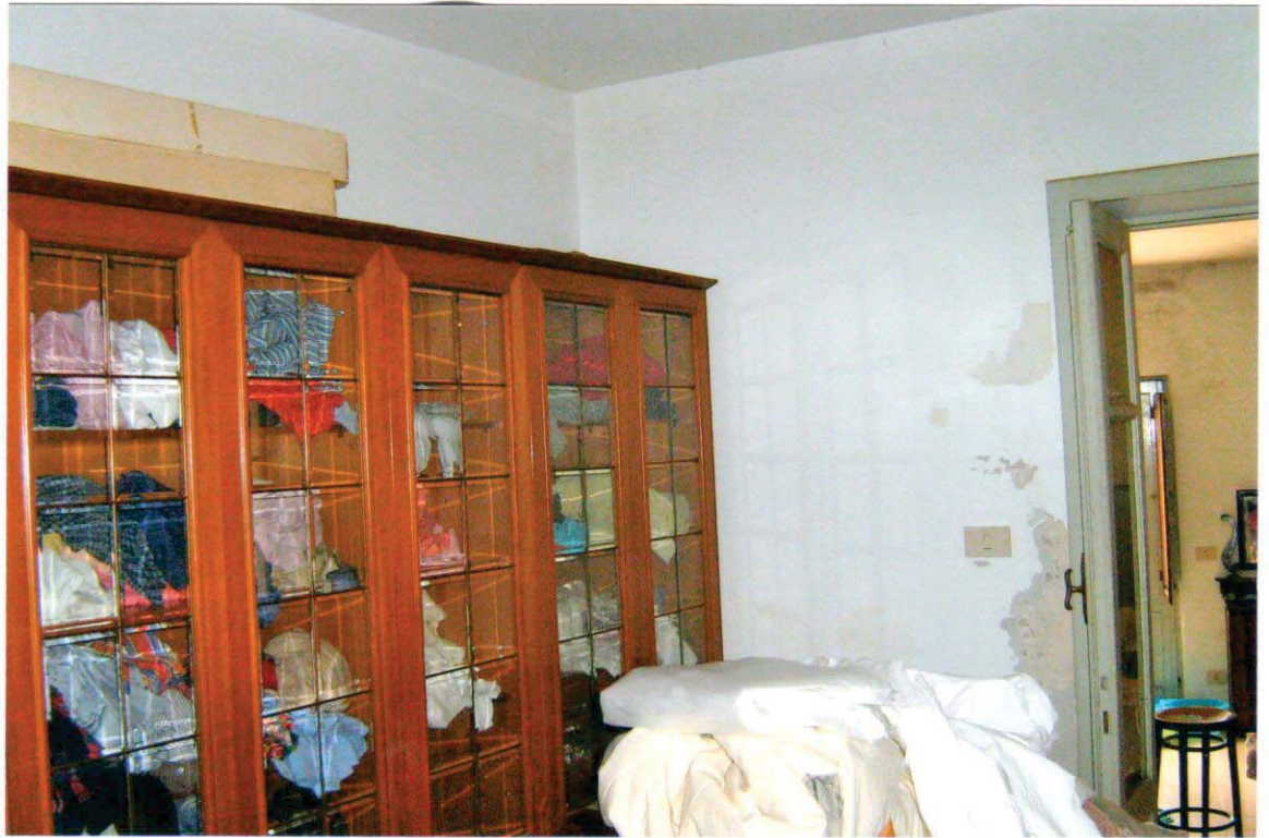
INTERNO PIANO TERRA
