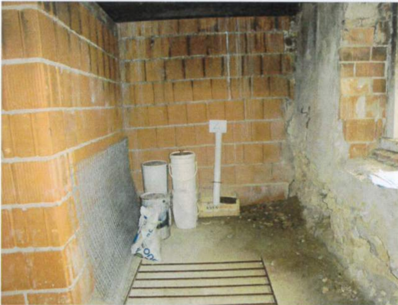
Unità mapp. 979 sub. 4 a piano terra: accesso da finestra e interni
