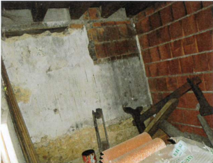
Interni unità mapp. 979 sub. 1 a piano terra
