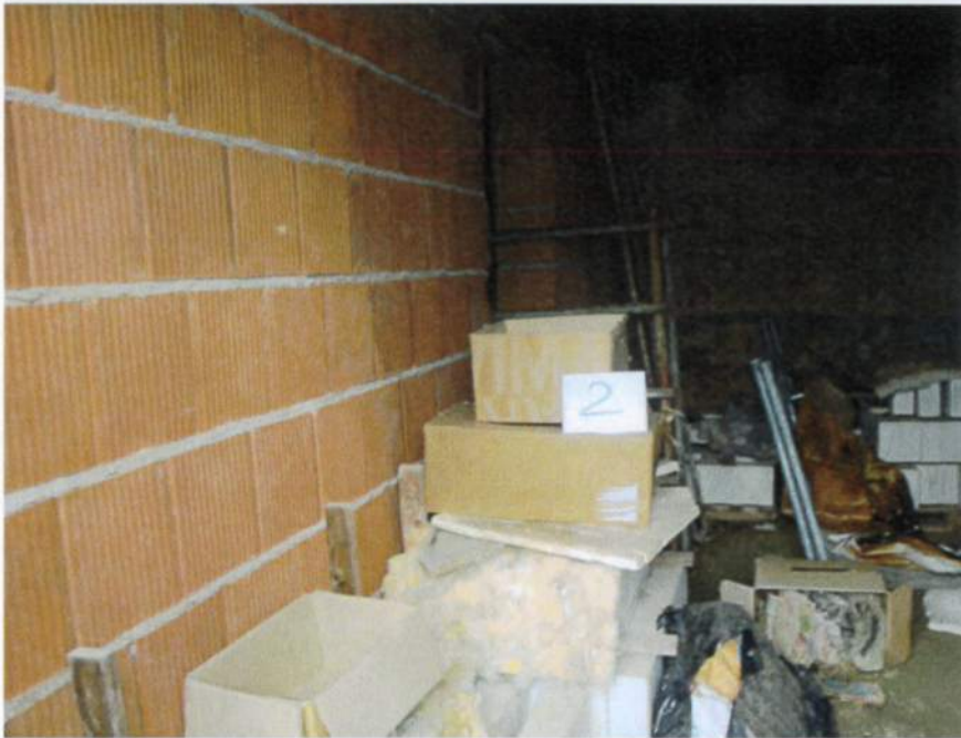
Interni unità mapp. 979 sub. 2 a piano terra
