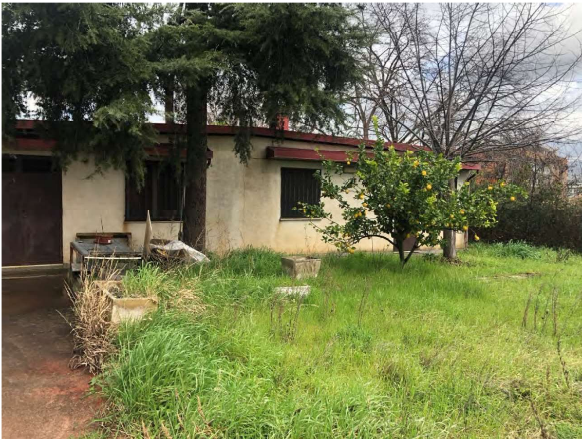
Foto 22 - Magazzino Rende, fg.50, p.IIa 809, sub.2-3
