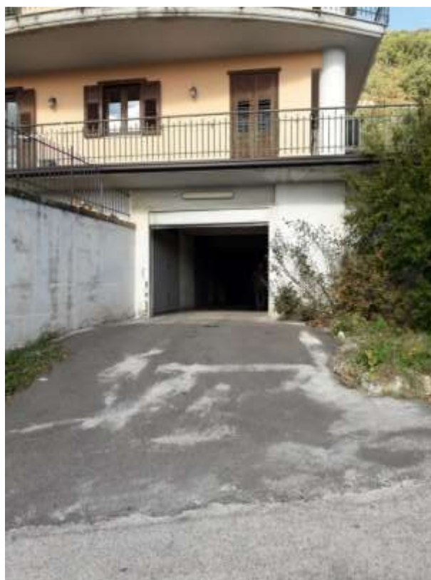
Foto n. 12: l'ingresso al piano seminterrato
