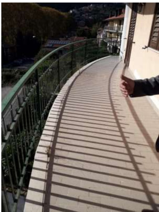
Foto n. 11: il balcone frontale
