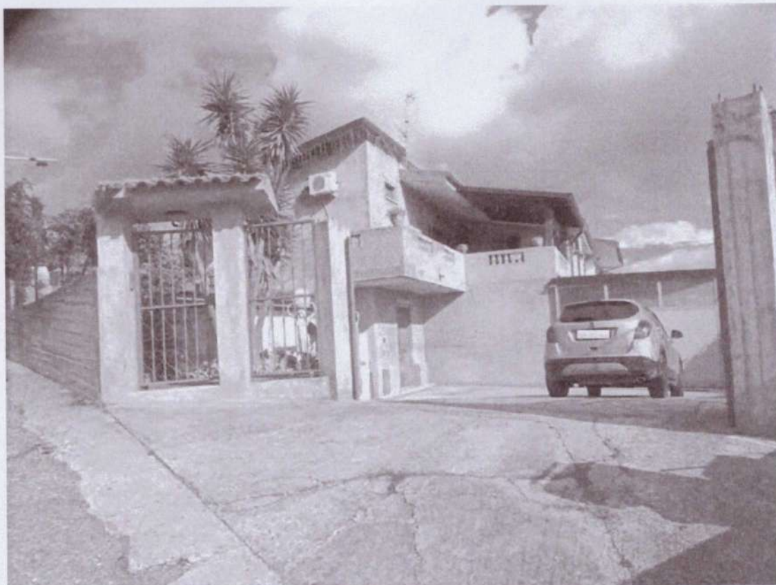
Foto 3. Piano terra – Rampa di accesso all'immobile
