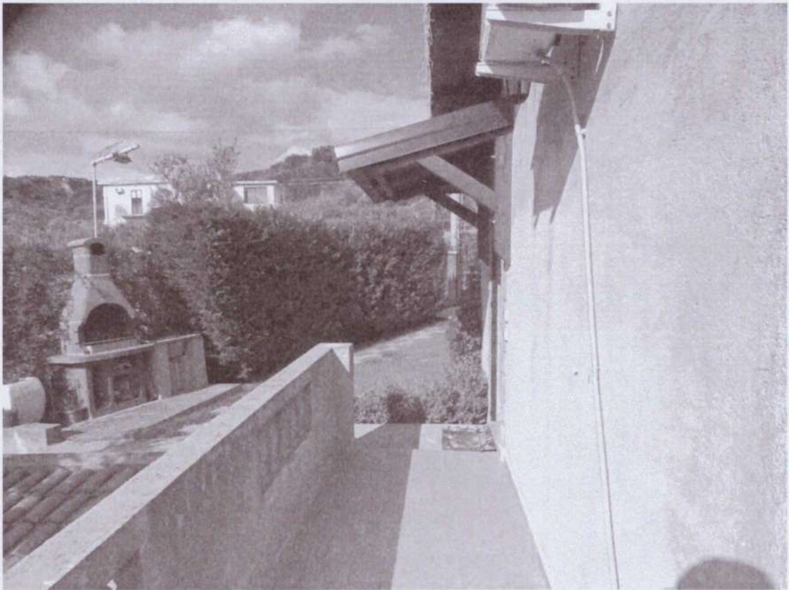
Foto 16. Piano primo – Balcone
