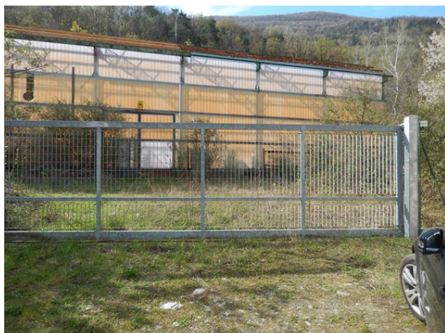
Cancello di accesso alla proprietà
