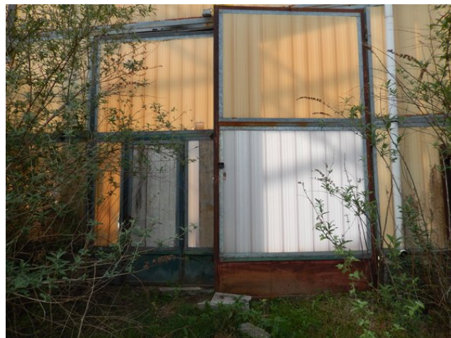
Porta accesso capannone
