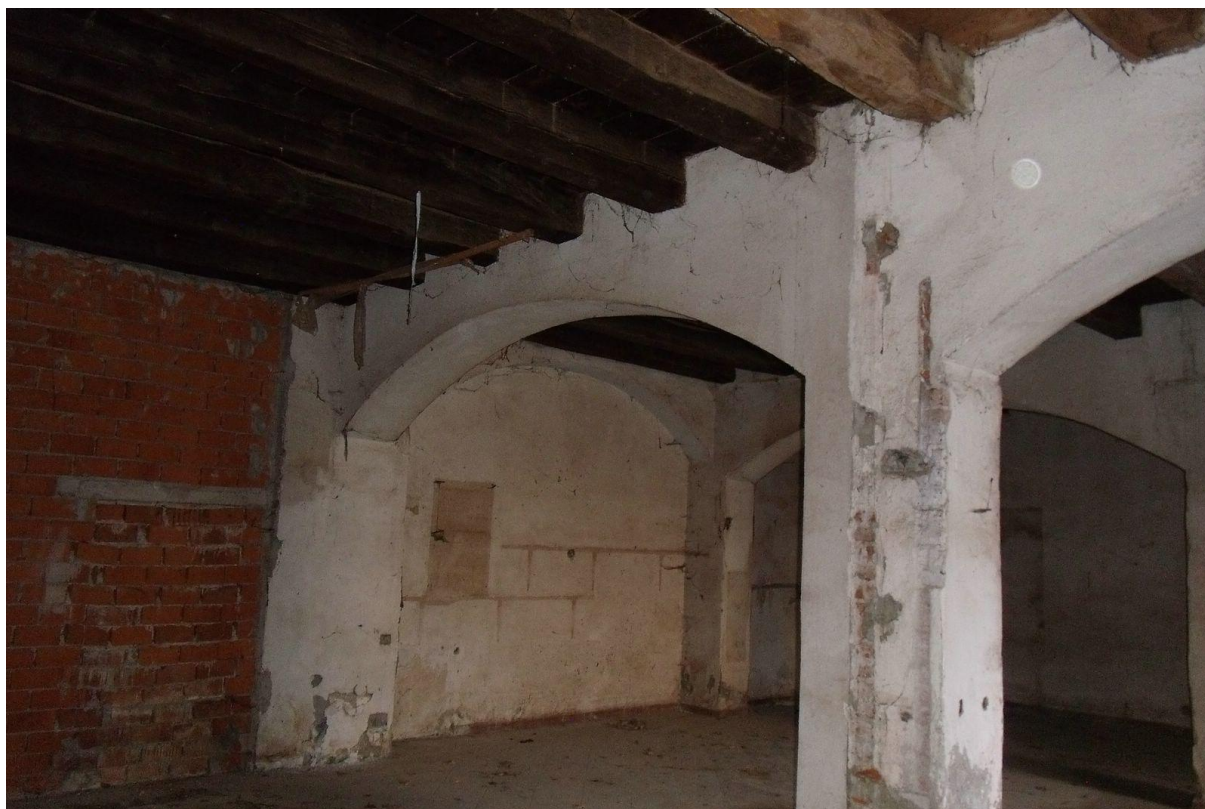
FOTO 15 IL PIANO TERRENO DEL SECONDO CORPO DI FABBRICA
