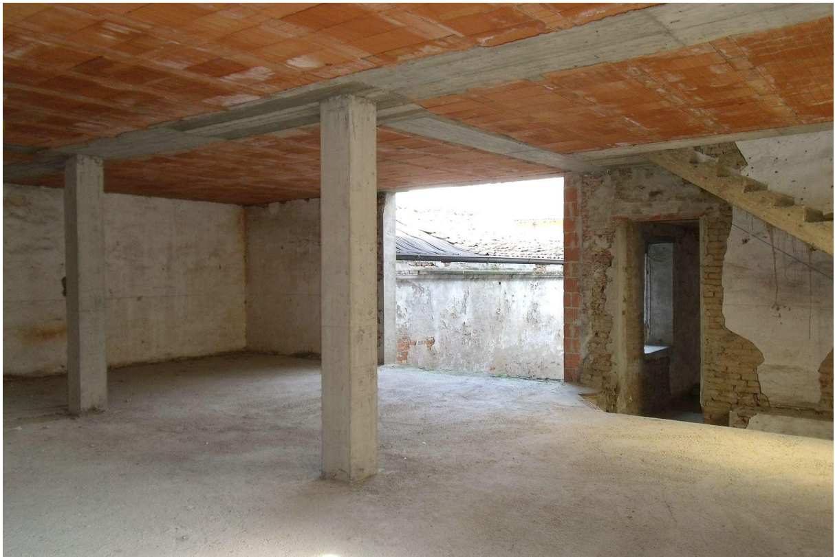
FOTO 19 IL PIANO PRIMO DEL SECONDO CORPO DI FABBRICA
