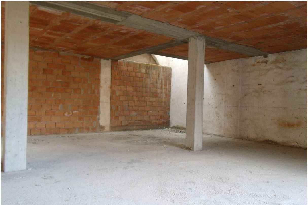
FOTO 18 IL PIANO PRIMO DEL SECONDO CORPO DI FABBRICA
