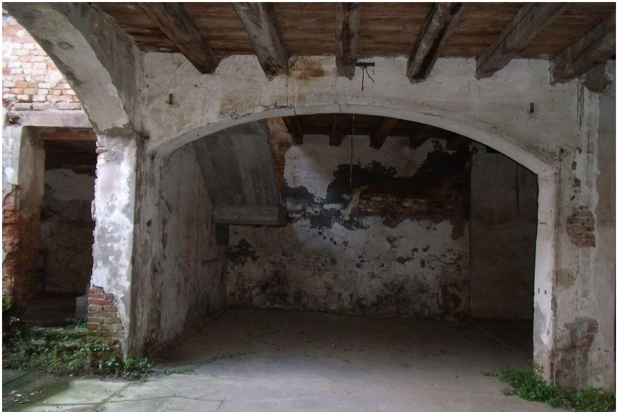
FOTO 14 IL PIANO TERRENO DEL SECONDO CORPO DI FABBRICA
