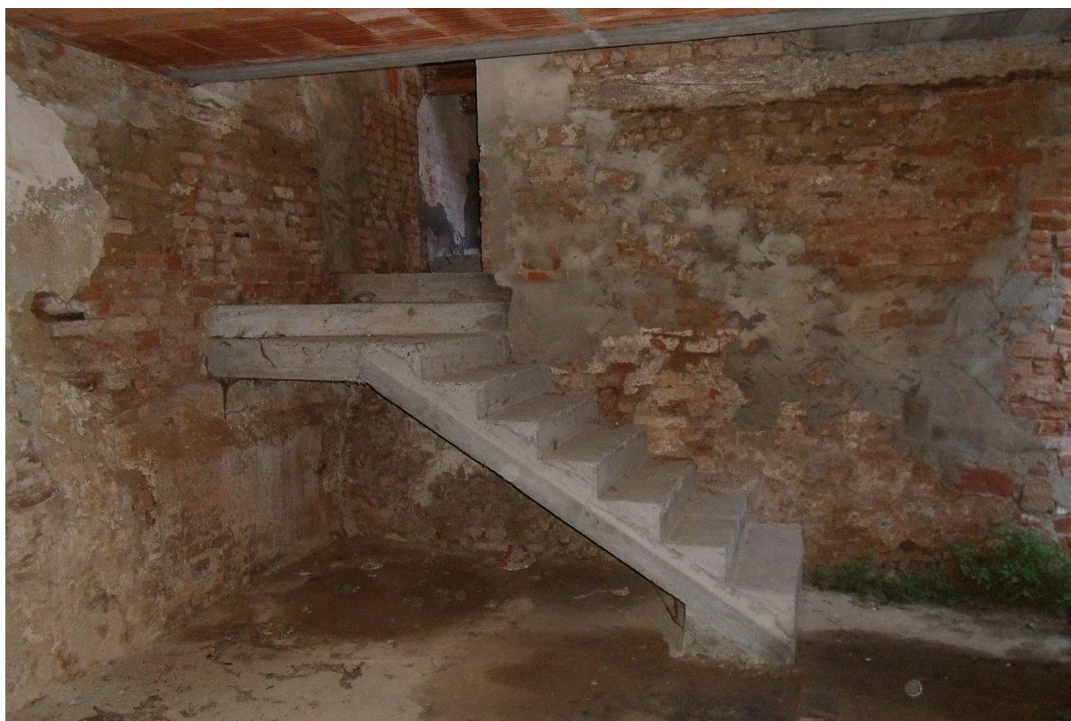
FOTO 8 LA SCALA AL PIANO TERRENO VISTA DAL PRIMO CORPO DI FABBRICA
