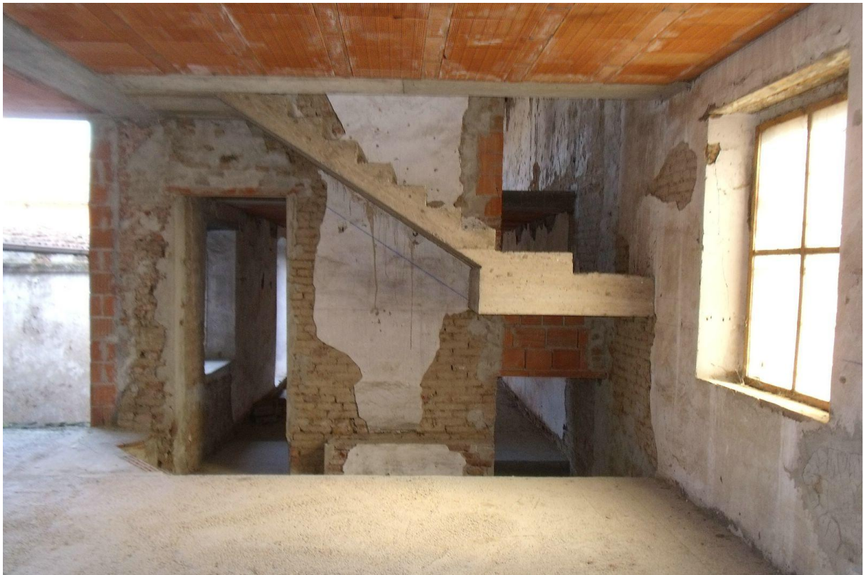
FOTO 20 IL PIANO PRIMO DEL SECONDO CORPO DI FABBRICA
