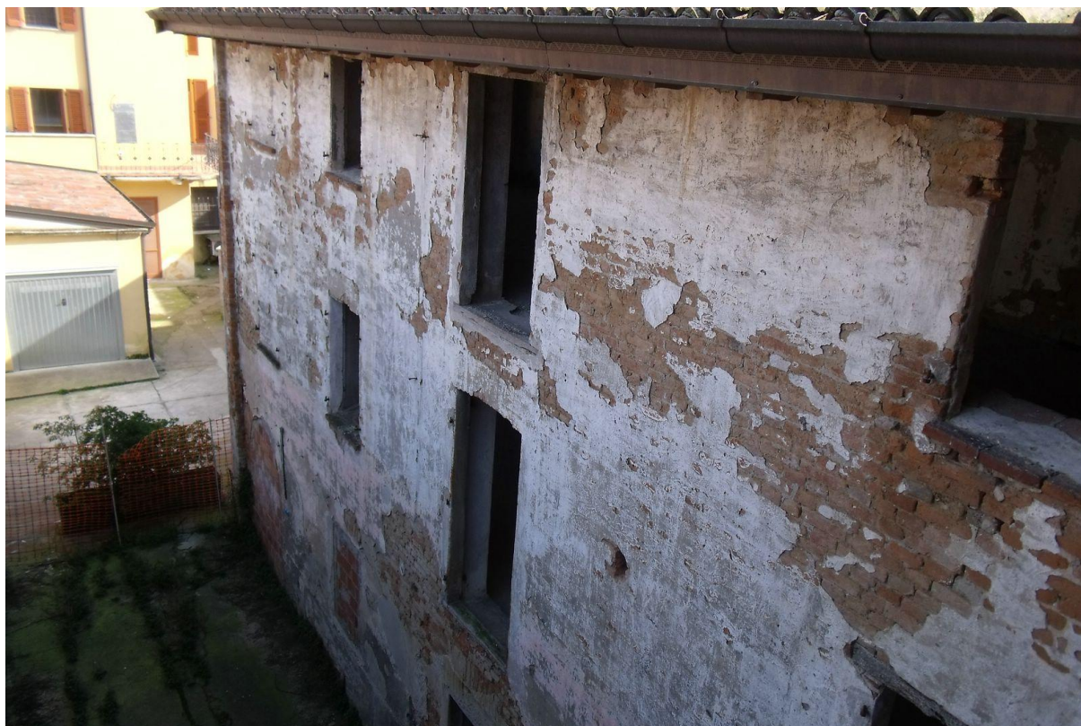
FOTO 5 VISTA DAL PIANO SECONDO VERSO IL CORTILE COMUNE
