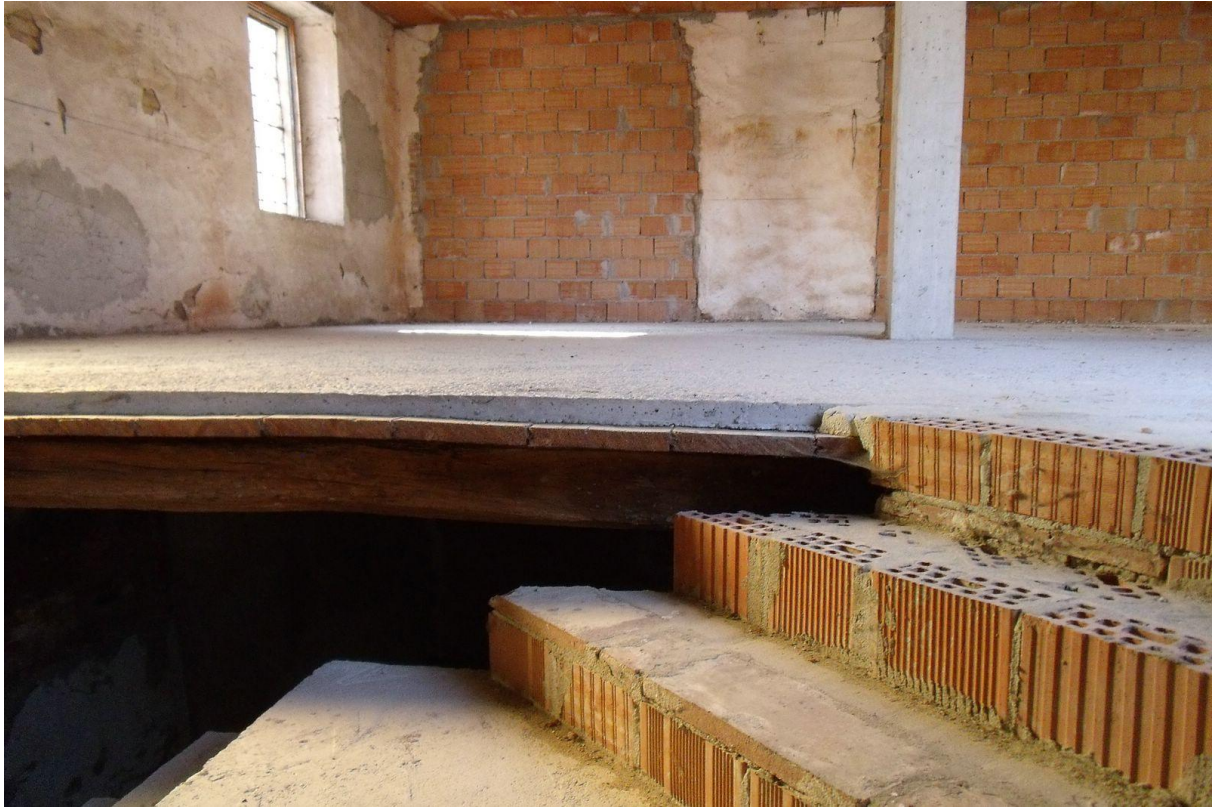
FOTO 17 IL PIANO PRIMO DEL SECONDO CORPO DI FABBRICA
