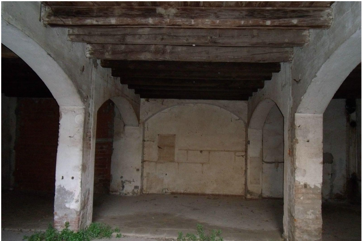
FOTO 13 IL PIANO TERRENO DEL SECONDO CORPO DI FABBRICA
