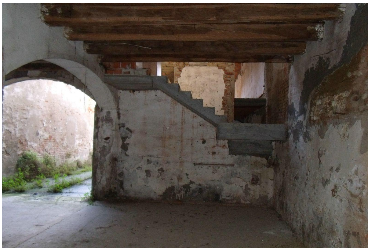
FOTO 16 IL PIANO TERRENO DEL SECONDO CORPO DI FABBRICA
