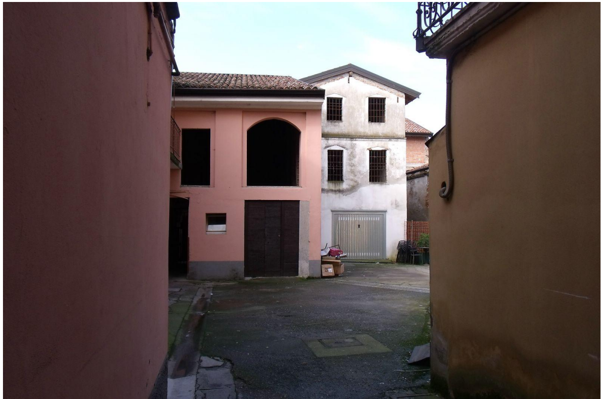
FOTO 2 IL CORTILE COMUNE. IL FABBRICATO E' QUELLO BIANCO
