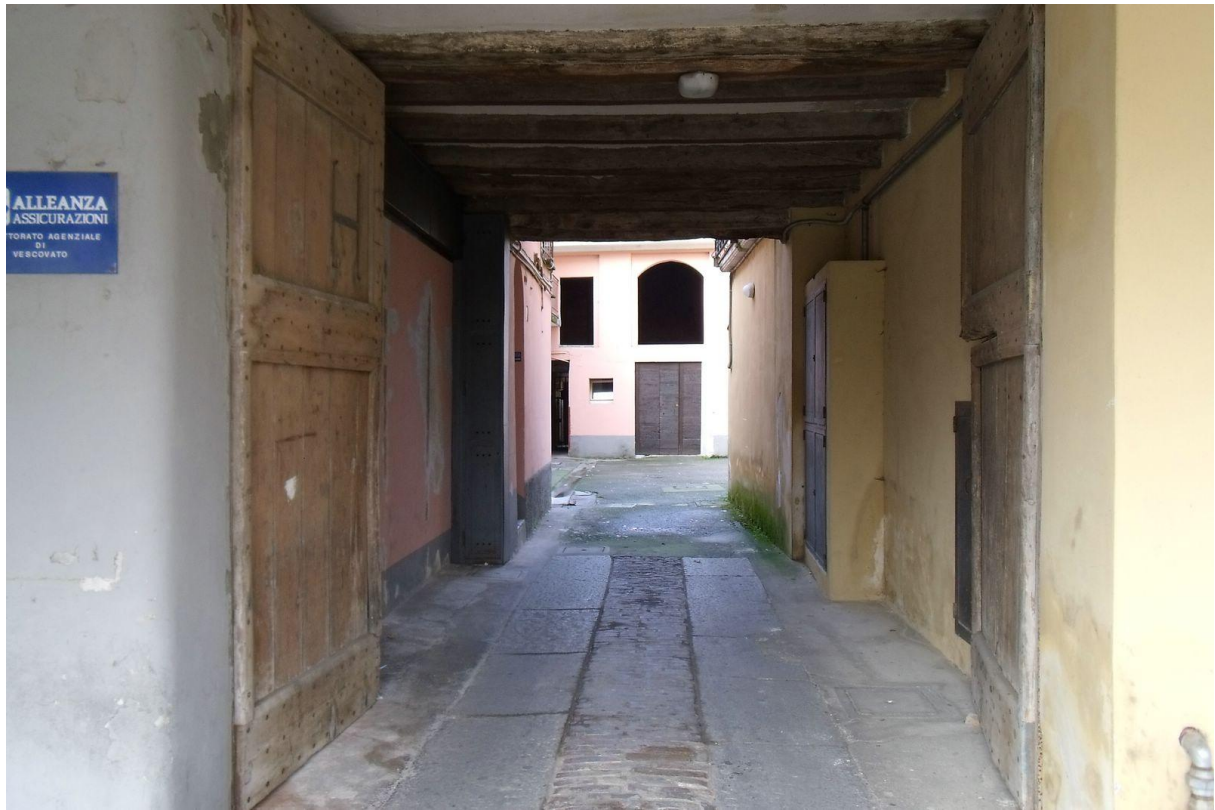
FOTO 1 L'ACCESSO DAL PORTICO SU PIAZZA ROMA
