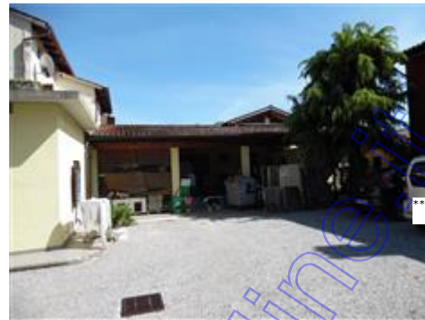
Prospetto nord-ovest tettoia
