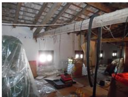
Abitazione, sub. 4 - Soffitta al p.2
