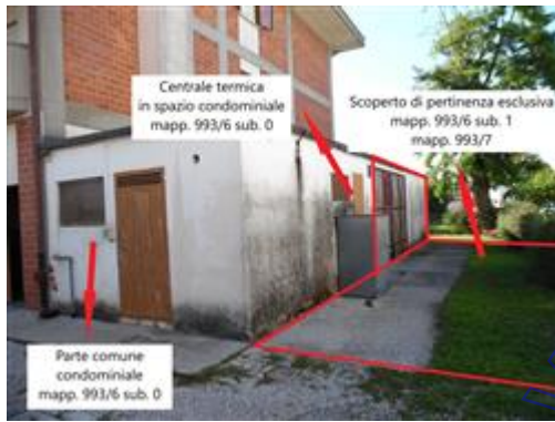
Prospetto Sud-Est fabbricato condominiale e Nord-Est vano tecnico e ufficio, con scoperto di pertinenza esclusiva
