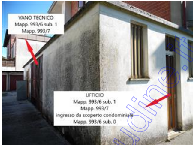
Prospetto Nord-Est vano tecnico (motori frigoriferi) e Nord-Ovest ufficio
