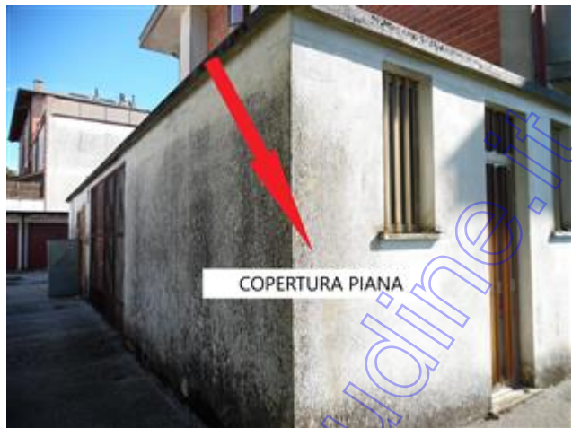
Copertura piana corpo di fabbrica a Nord-Est
