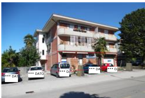
Prospetto Sud-Ovest da Via E. Curjel - Ingresso principale negozio
