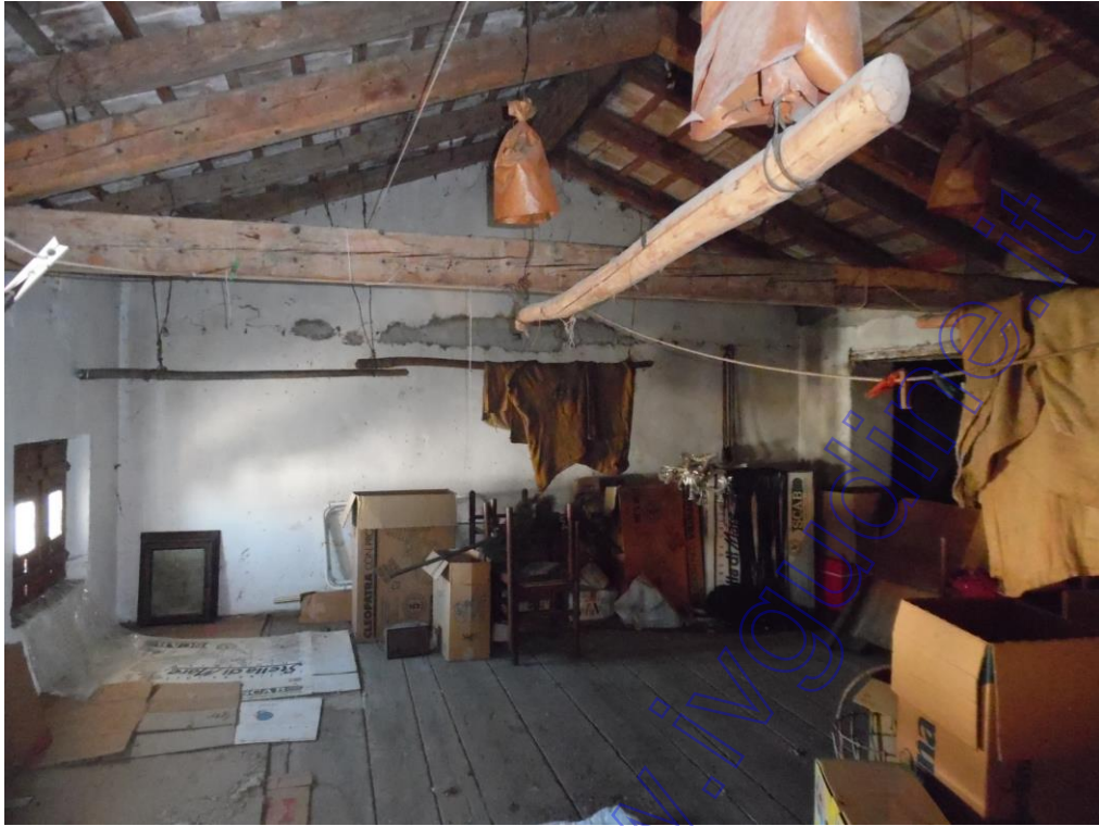
Soffitta p.2 (sub. 4)
