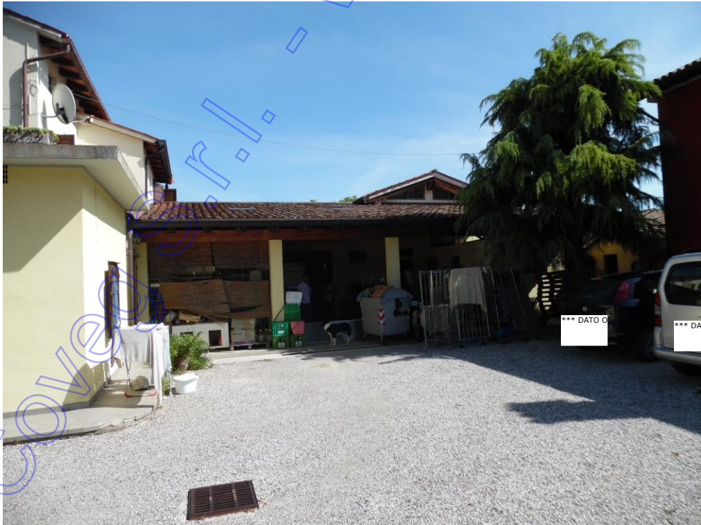
Scoperto pertinenziale e tettoia abusiva
