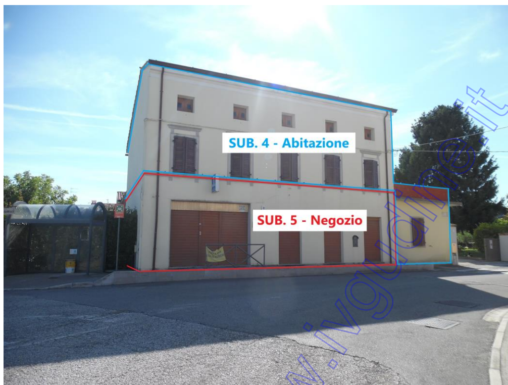
Prospetto N/E da fronte strada Via Gramsci
