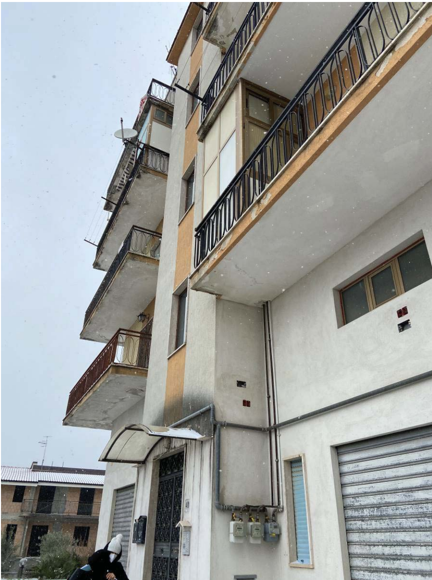
Foto n. 18 - Visione fabbricato con ingresso civico 40
