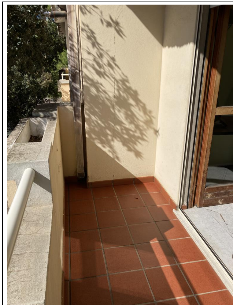
Foto 14 - Immobile A - Veranda 2
