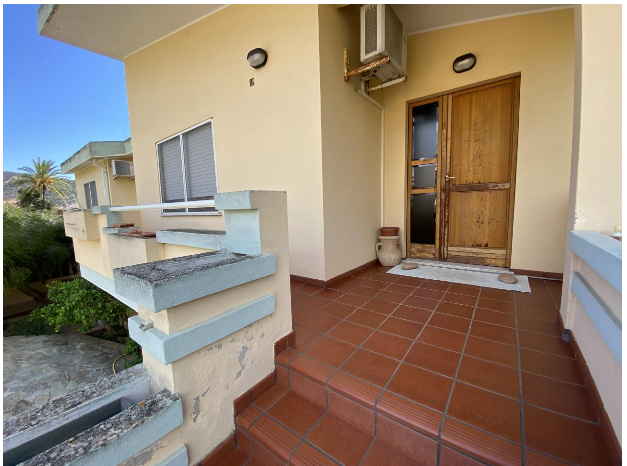
Foto 4 - Immobile A - Balcone
