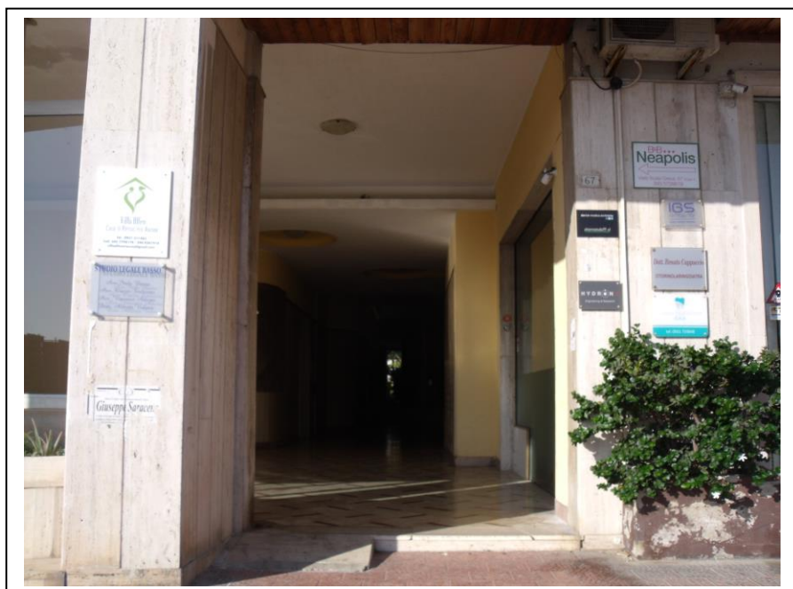
02. Ingresso del complesso edilizio dal viale Scala Greca, n. civico 67, percorso area condominiale con accesso diretto dal lato strada, presenza di marciapiede.
