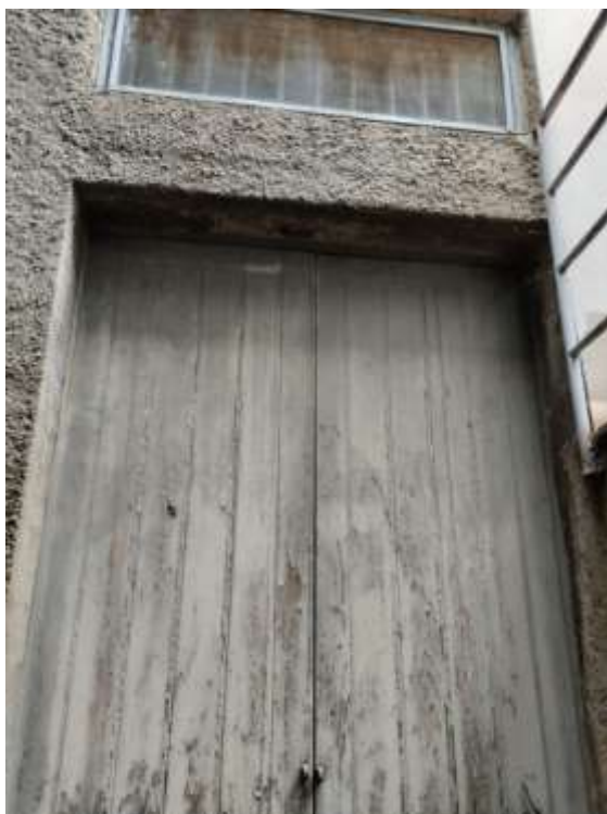
Foto n. 11 – Ingresso al deposito piano terra part. 242 sub. 9
