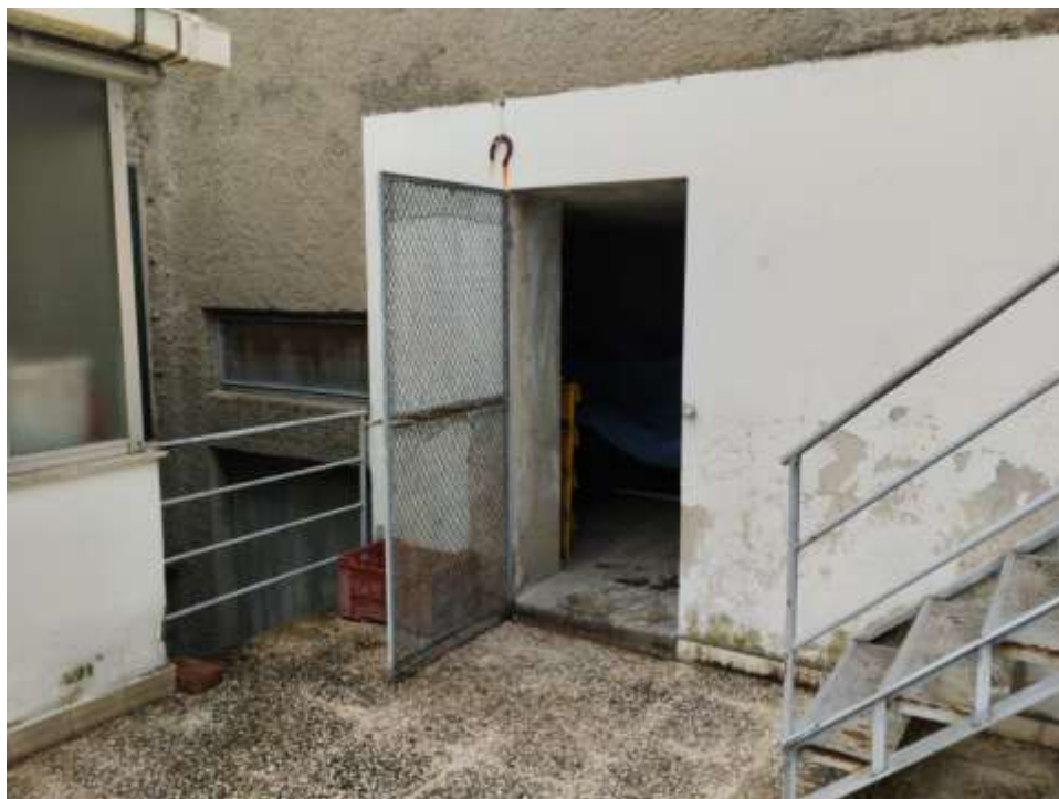
Foto n. 12 – accesso deposito piano primo part 242 sub. 10
