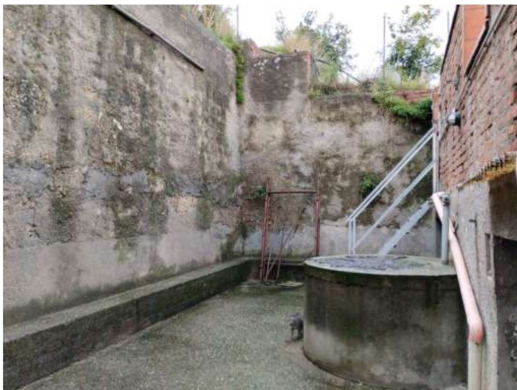
Foto n. 10 – Corte esterna aggraffata alla part. 242
