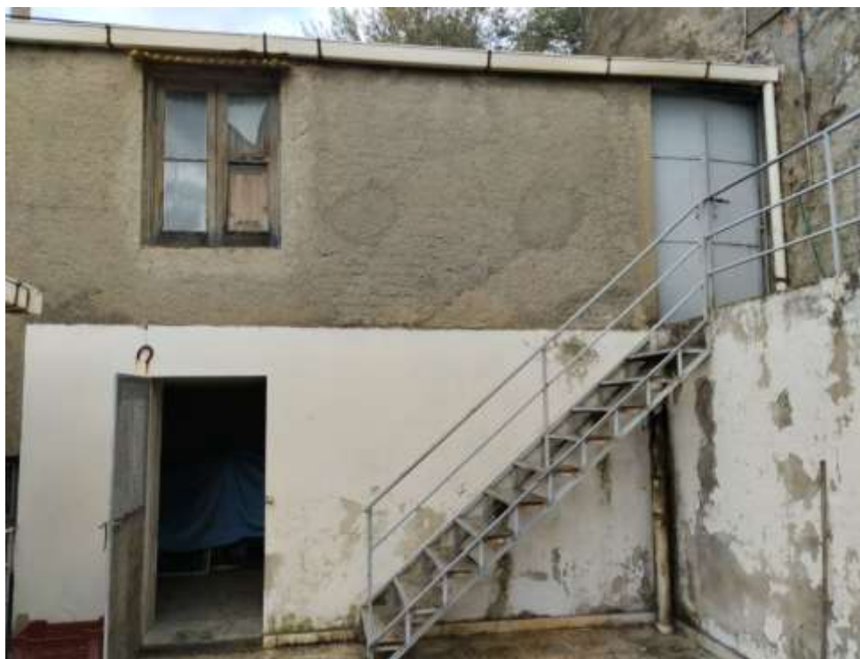
Foto n. 13 – deposito piano secondo part. 242 sub. 11
