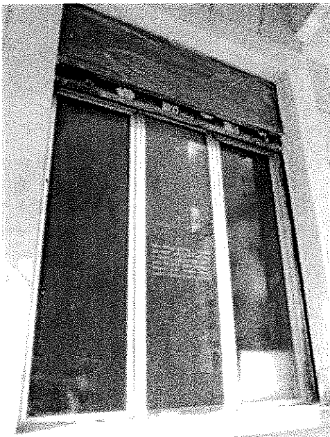
Infissi esterni ex locali 3 e 4
