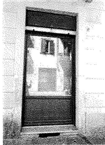
Infissi esterni ex locali 5 e 5bis
