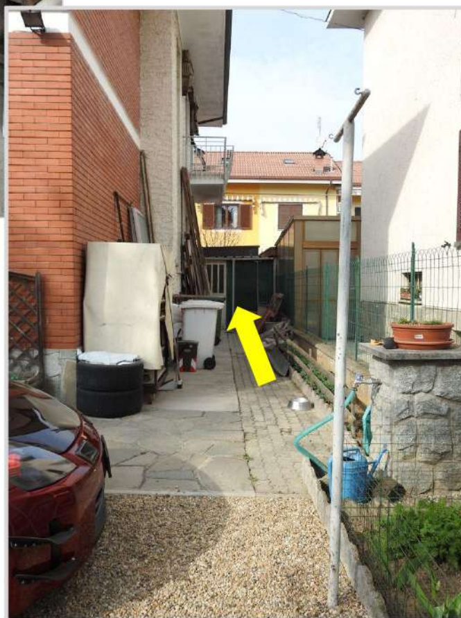
A fianco: vista dell'ingresso alla tettoia sub. 7 evidenziato dalla freccia di colore giallo
