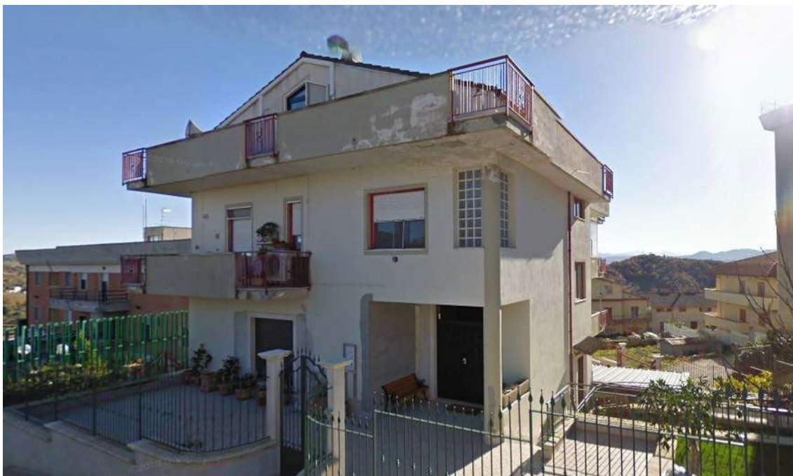
Fotogramma 03 – Vista esterna della fabbricato multipiano – In Catasto F. 29 p.la 482
