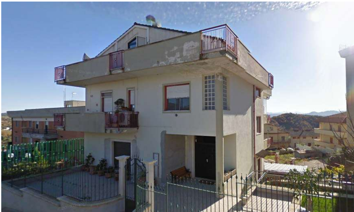
Fotogramma 04 – Vista esterna della fabbricato multipiano – In Catasto F. 29 p.IIa 482
