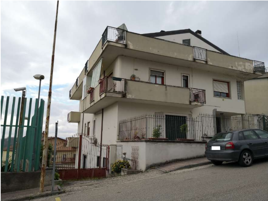
Fotogramma 03 – Vista esterna della fabbricato multipiano – In Catasto F. 29 p.IIa 482
