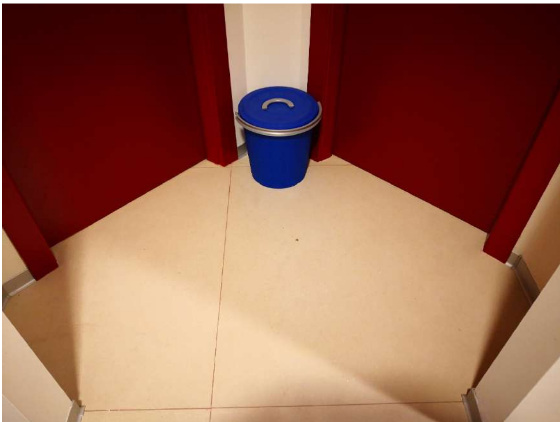
Fotogramma 10 – Unità immobiliare al P.T. – F. 29 p.Ila 482 sub 7 – Unità immobiliare commerciale – particolare disimpegno wc/ripostiglio
