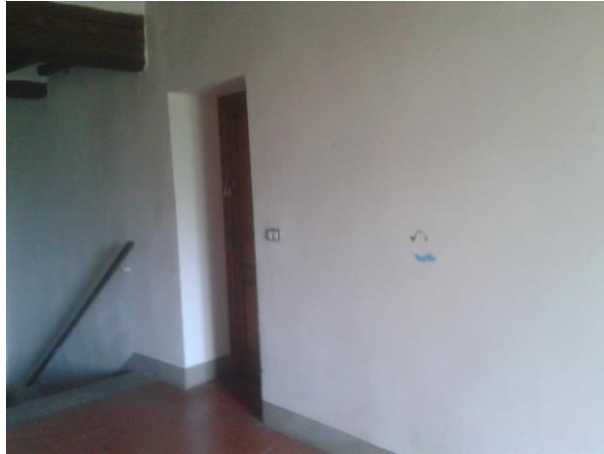
Accesso camera 2 da altra proprietà adiacente
