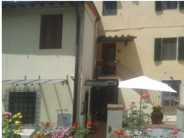
ingresso al P2 da scala comune
