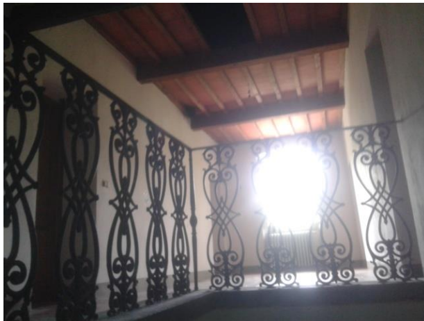
Proprietà adiacente ballatoio per accesso camera 2
