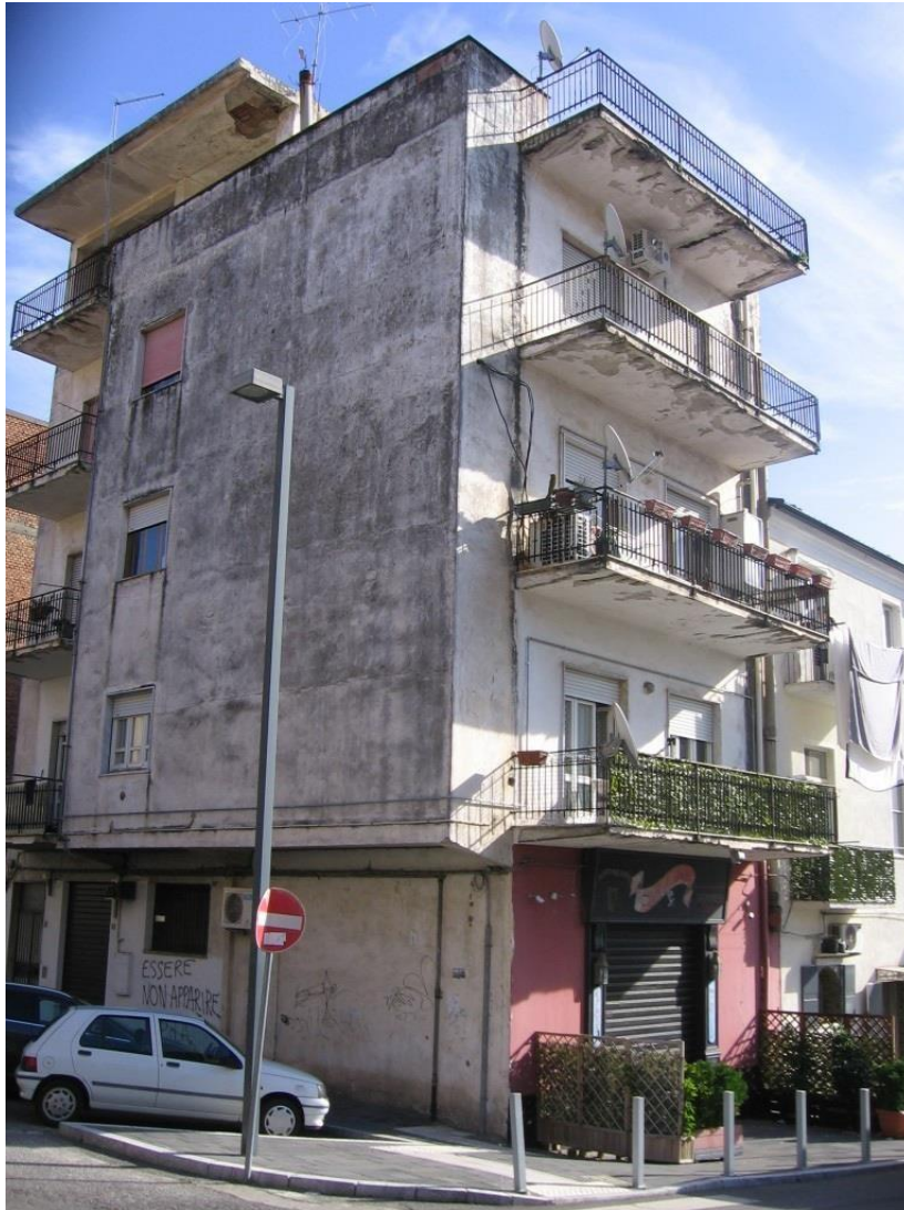
Prospetto Nord-Ovest del fabbricato
