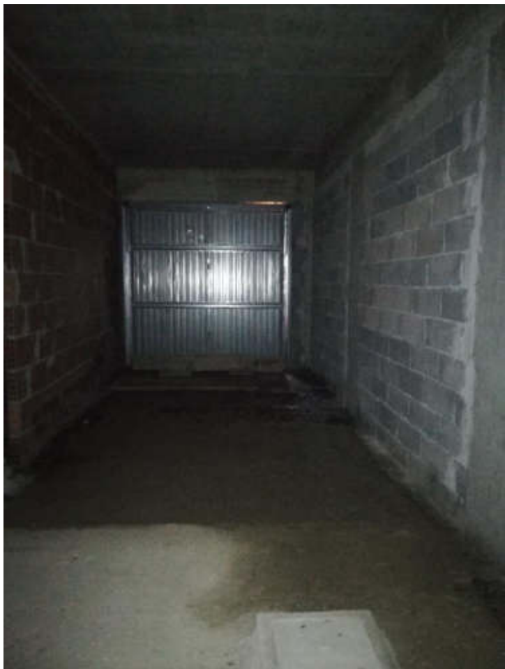
Foto 29 e 30 - Vista interna garage, piano S1
