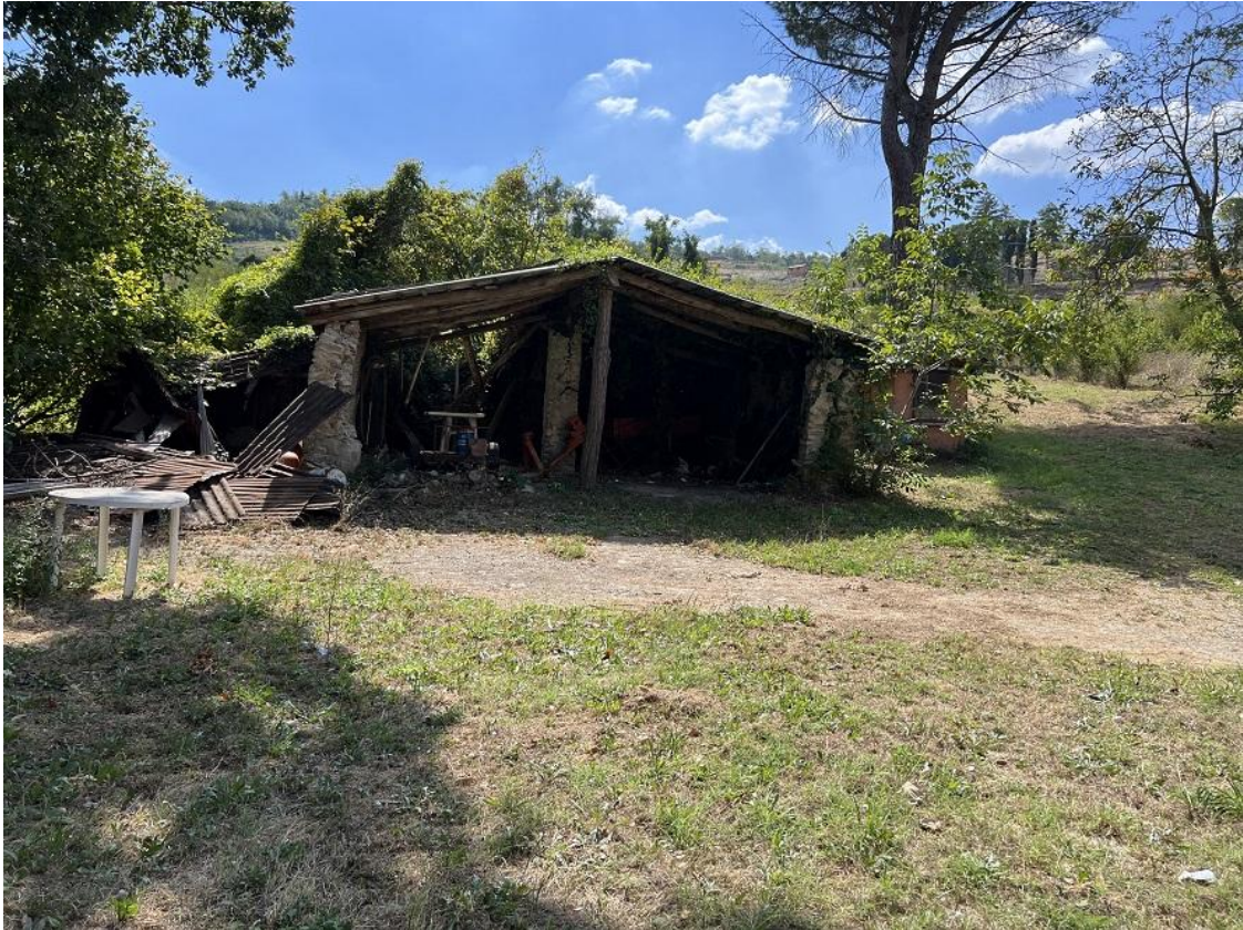
FABBRICATO B) SUB 2 PARTE DEPOSITO/TETTOIA SEMICROLLATA mq. 72 circa
