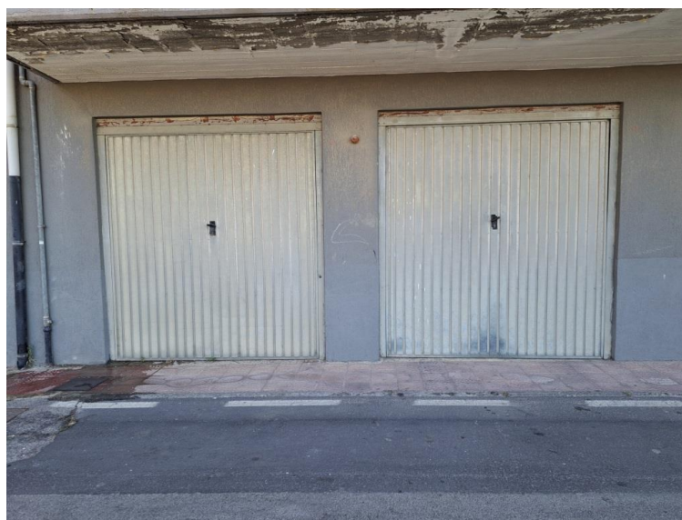
Vano garage (con due portoni d'ingresso)
