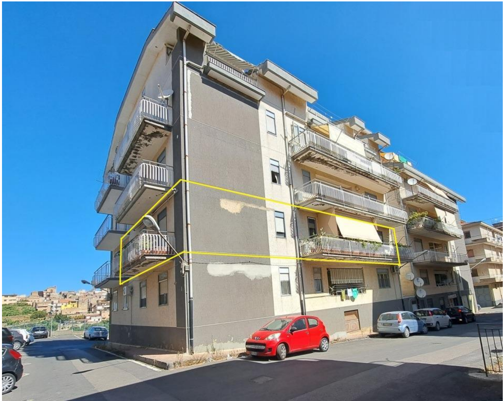
Foto 3 – Prospetto dell'edificio (su via Enrico Fermi angolo con via Puglie) con in evidenza l'appartamento pignorato
