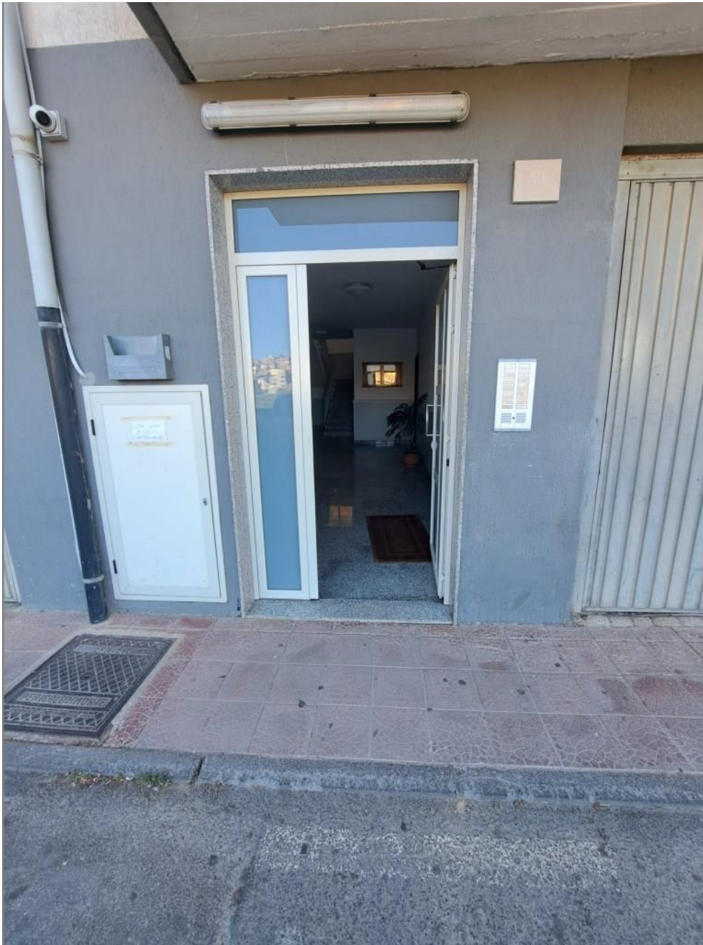
Foto 4 – Ingresso dell'edificio condominiale
