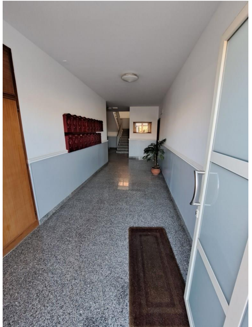
Foto 5 – Androne dell'edificio condominiale
