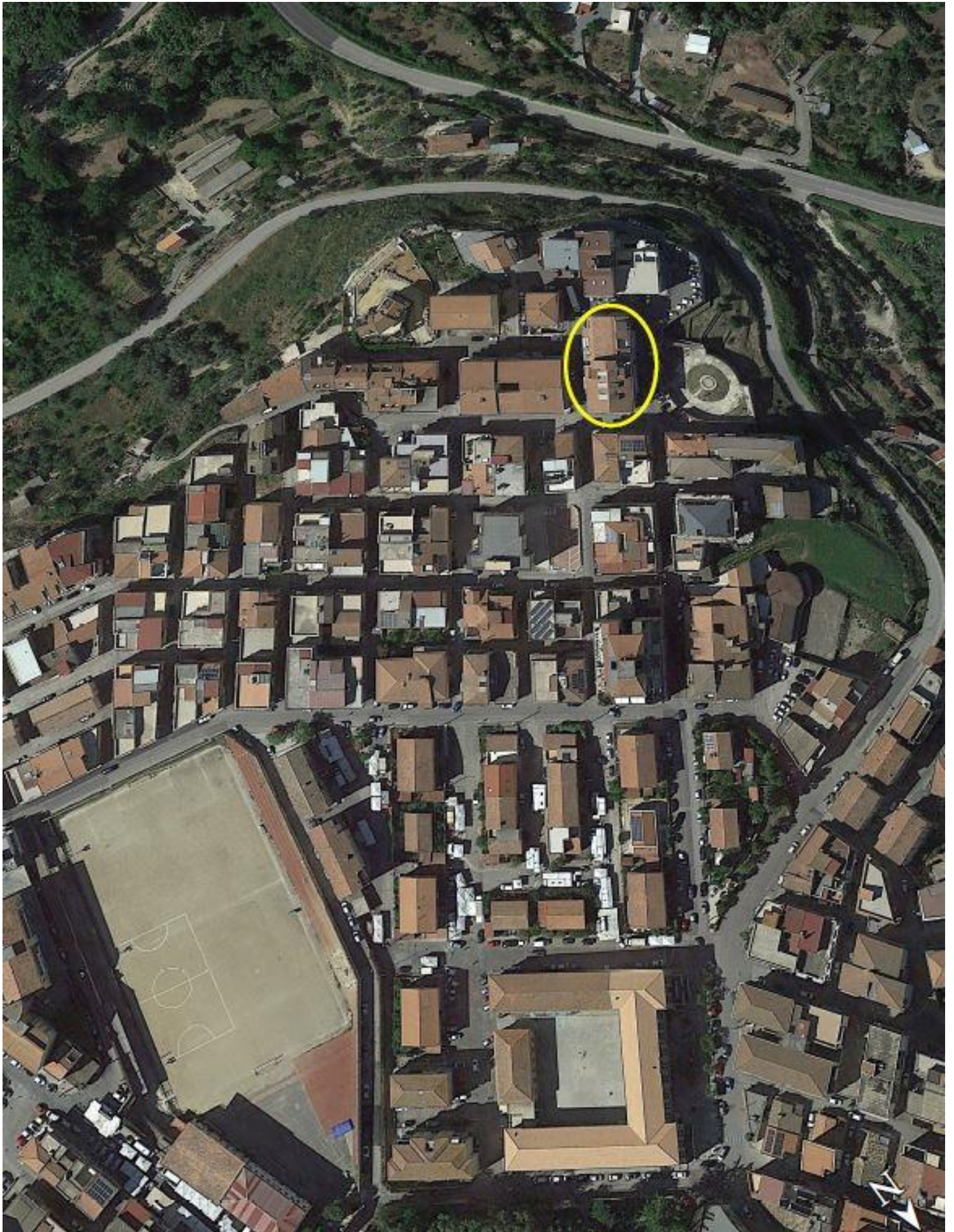
Foto 1 – foto aerea della zona in cui ricade il fabbricato a cui appartengono i beni pignorati
