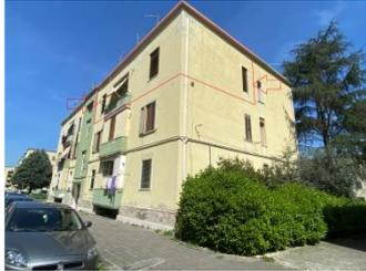
Struttura Verticale: in muratura ordinaria di tufo squadrato e malta cementizia; rifinitura con intonaco liscio con sovrastante tinteggiatura.
