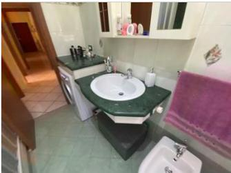
pavimentazione realizzato con piastrelle posate a colla su massetto di sabbia e cemento, suggellatura dei giunti con fuga in cemento di colore chiaro, spessore cm. 0,3;
