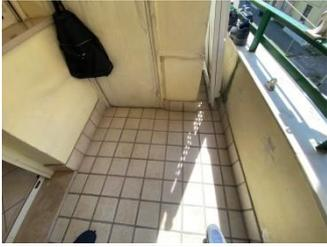
pavimentazione realizzato con piastrelle in clinker posate a colla su massetto di sabbia e cemento, suggellatura dei giunti con fuga in cemento di colore chiaro, spessore cm.
