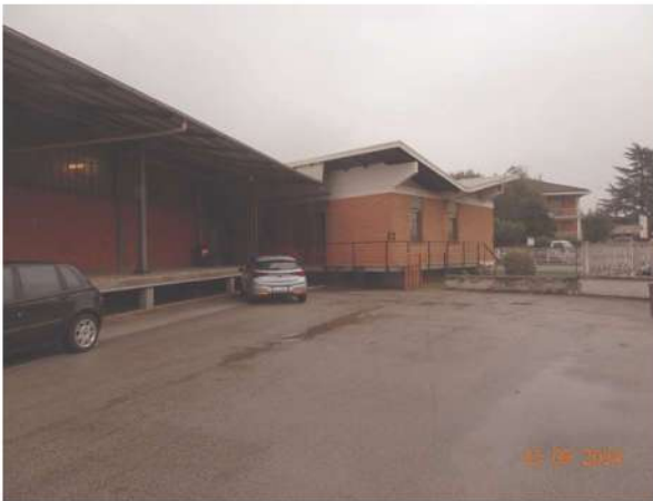
Piazzale esterno piano T
