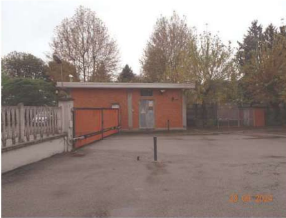
Cabina elettrica piano T
