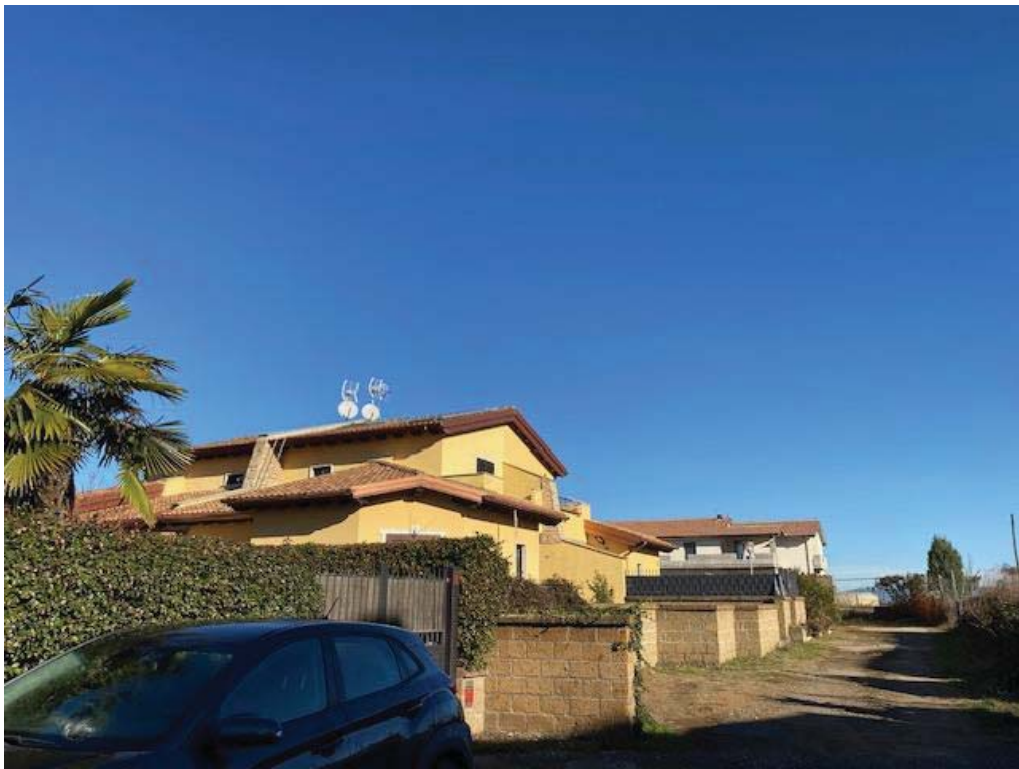
VISTA DALLA STRADA INTERNA
