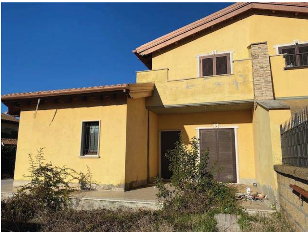
VISTA PROSPETTO PRINCIPALE
