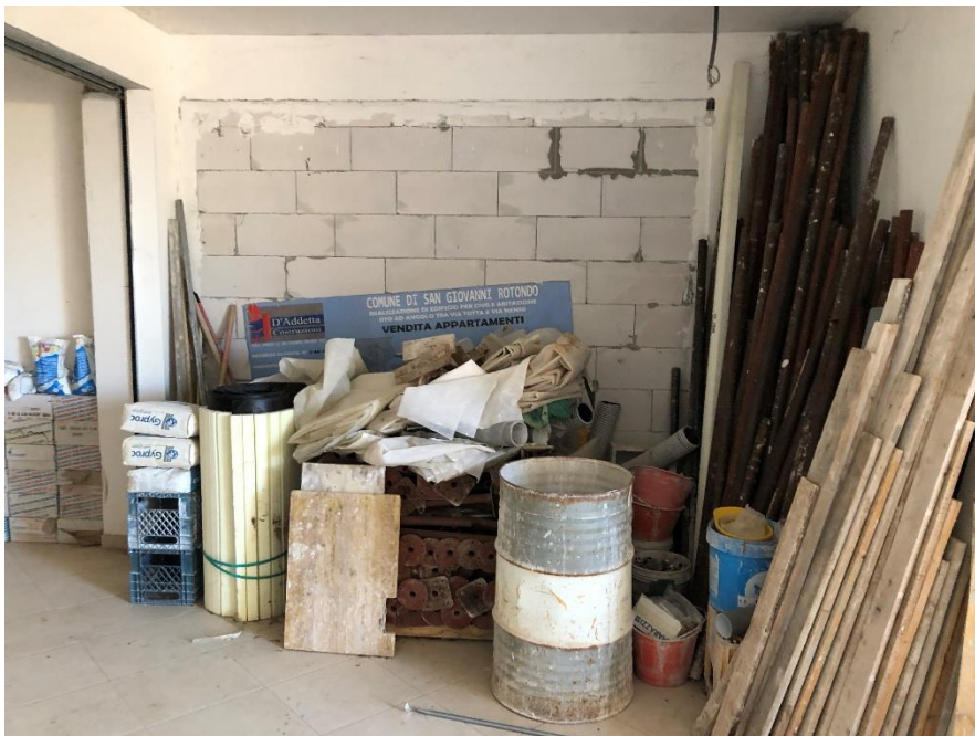
Foto n. 4: Ingresso murato del sub. 28
