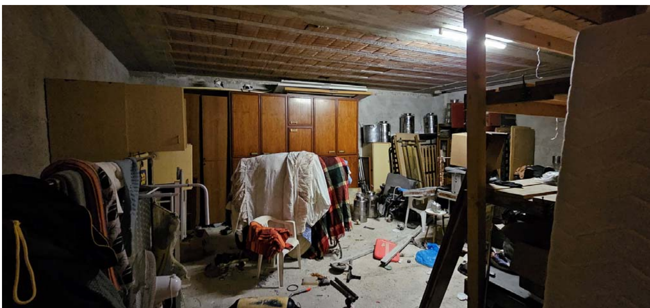
Vano difforme: deposito piano terra
