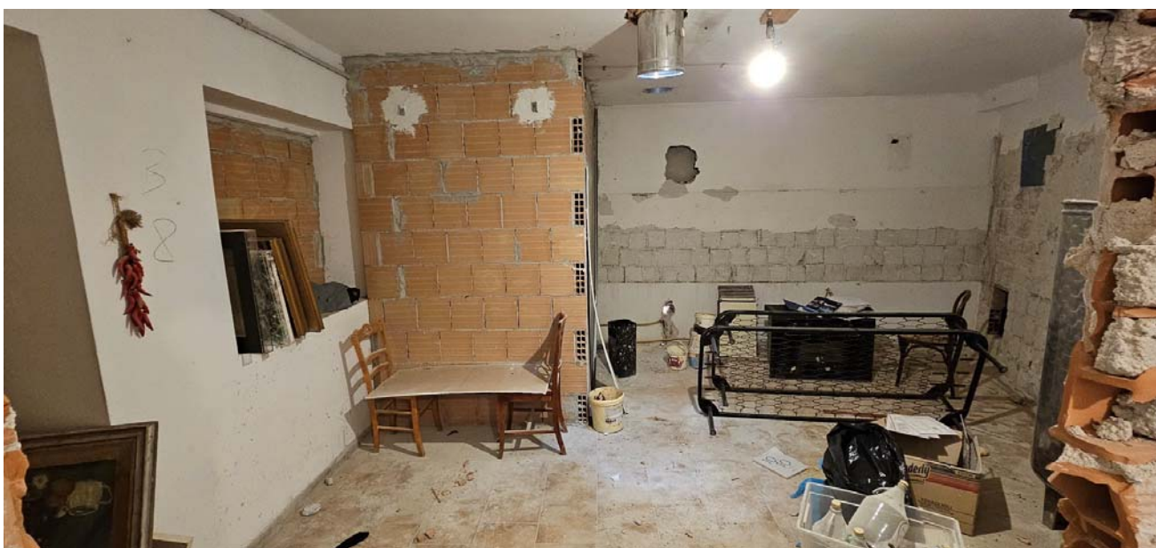
Vano difforme: magazzino piano primo
