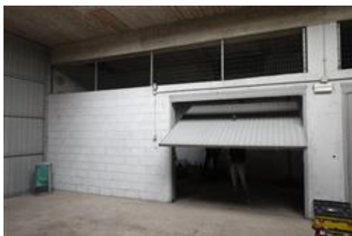
Rimessa con basculante aperto
